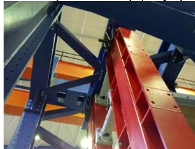
Σχήμα 4.13: Σύνδεση Άνω οριζόντιων συνδέσμων δυσκαμψίας
