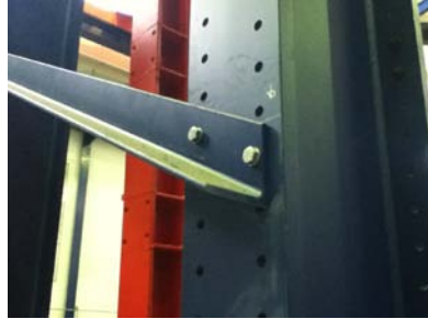
Σχήμα 4.12: Σύνδεση κατακόρυφων συνδέσμων δυσκαμψίας
