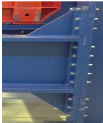
Σχήμα 4.6: Σύνδεση Δοκού σύζευξης - Υποστυλώματος
