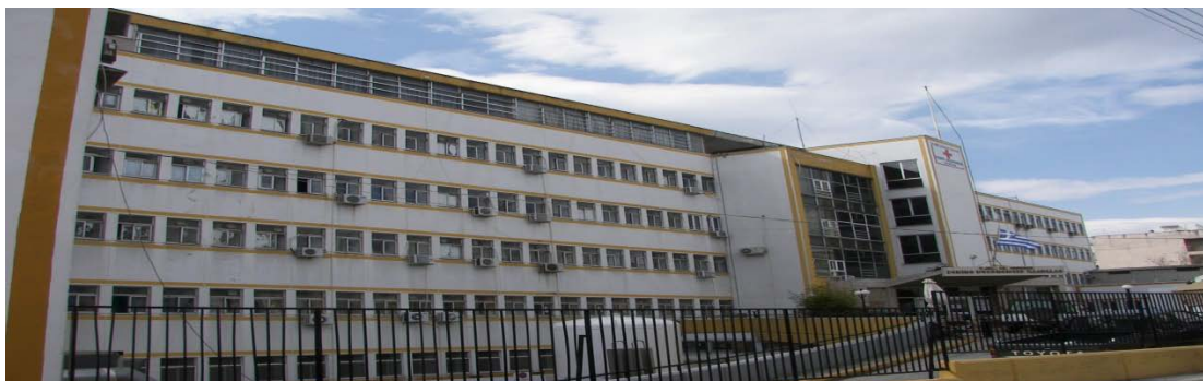
Γενικό Νομαρχιακό Νοσοκομείο Χαλκίδας ( έτος κατασκευής 1981)
