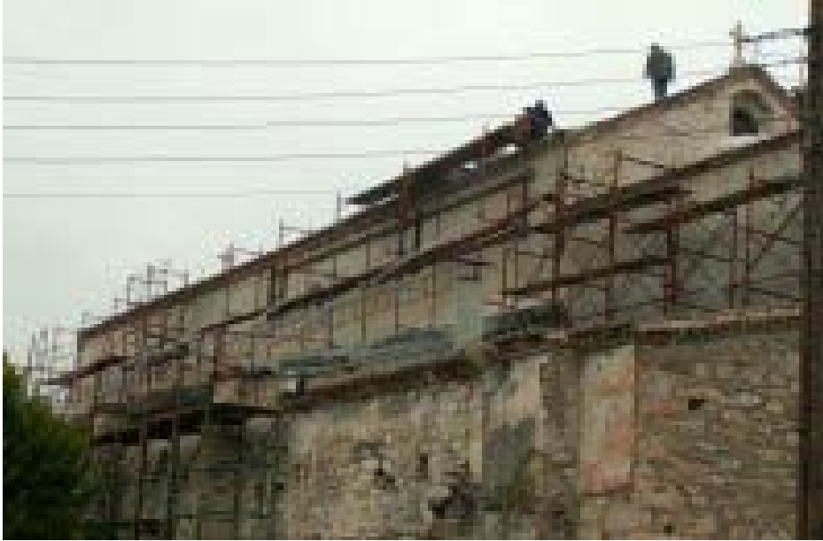
δίρριχτη ξύλινη στέγη κατά τη διάρκεια εργασιών
