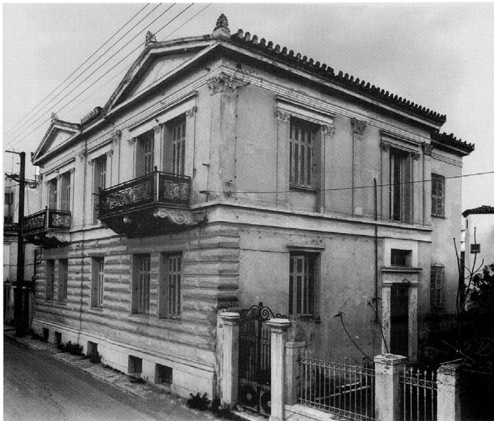
38. Σπίτι Φραγγιά, Π. Σταύρου 7. Κατεδαφίστηκε μετά το 1976. Φωτ. Μ. Βερνάρδος, 1973. (Γενική άποψη).
