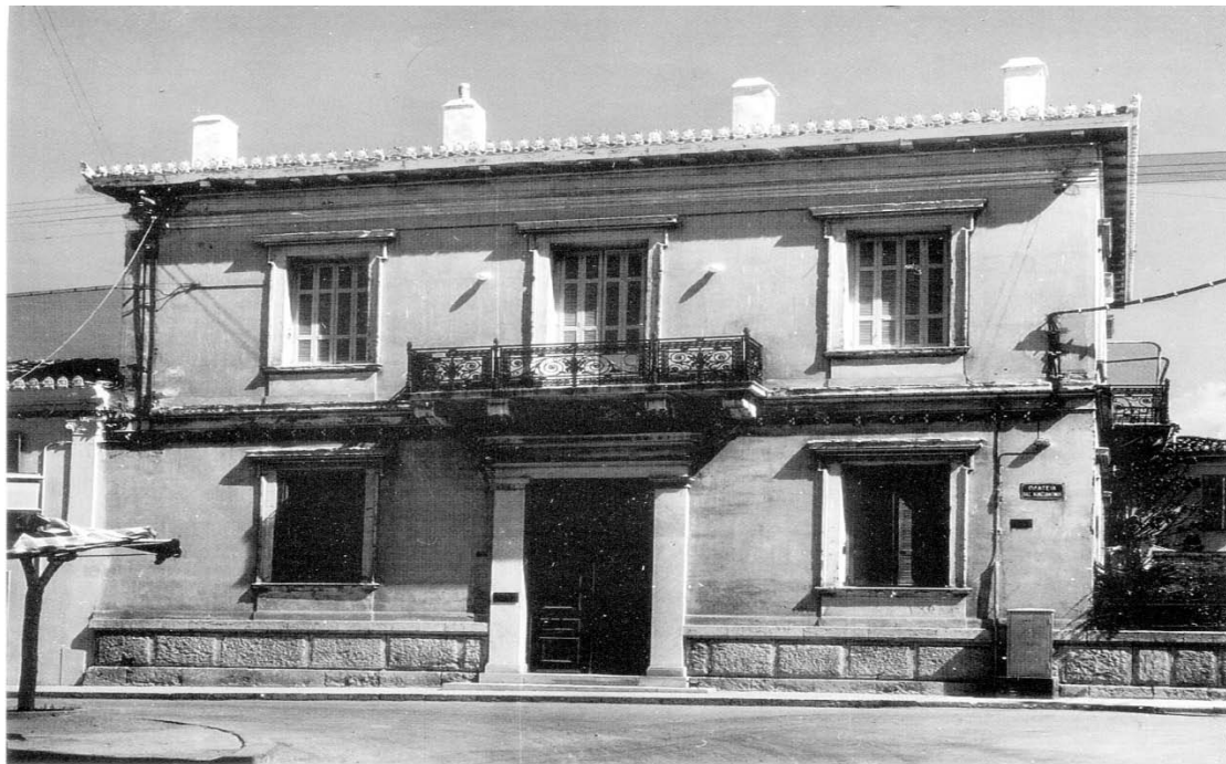
21. Σπίτι Πεζά, πλατ. Ηρώου. Κατεδαφίστηκε το 1969. Φωτ. Δ. Παπαδήμος, 1961-65. (Γενική άποψη). evia-halkida.blogspot.com
