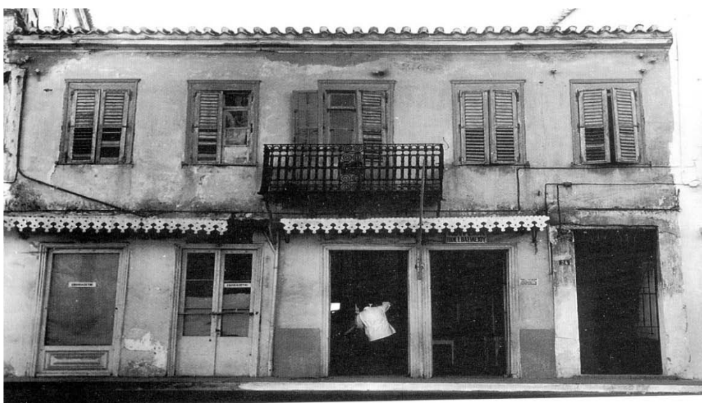
39. Σπίτι Φρ. Μαργαριτίδου, Αβάντων 24. Η χρονολογία στο μπαλκόνι: 1857. Κατεδαφίστην μετά το 1976. Φωτ. Δ. Παπαδήμος, 1961-65. (Γενική άποψη).
