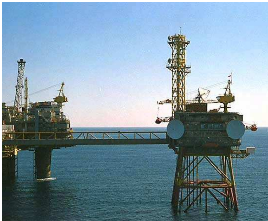
Εικόνα 2. Άποψη της πλατφόρμας εξόρυξης QP.
