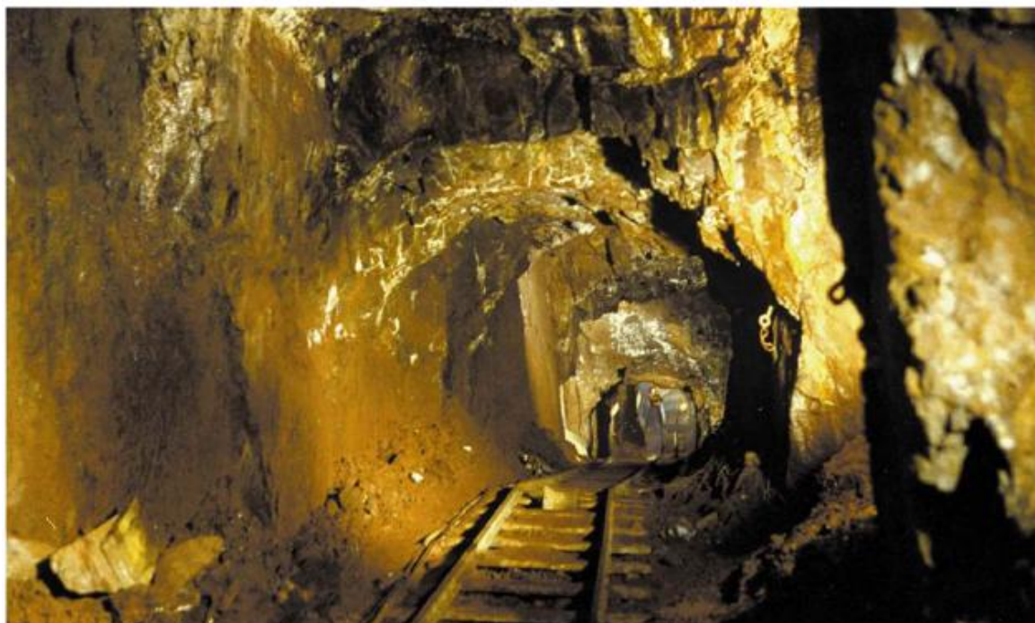
Εικόνα 5.7: Φωτογραφία σήραγγας μεταλλείου στο May-sur-Orne (Geostock, 2010).
