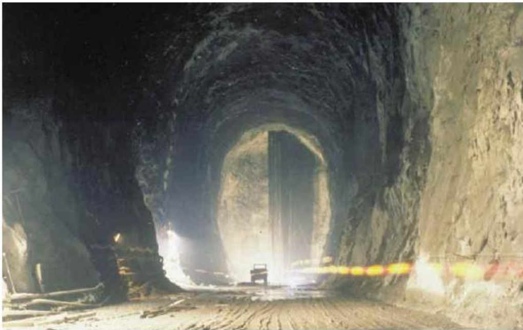
Εικόνα 2.5: Εσωτερικό οριζόντιου υπόγειου θαλάμου στην περιοχή Yosu στη Ν.Κορέα (Geostock, 2012).
