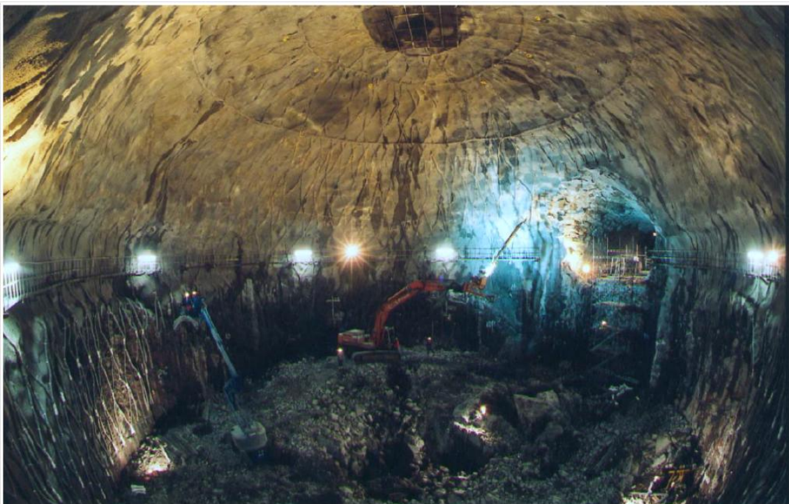
Εικόνα 5.32: Το τέλος εκσκαφής της στέγης του υπόγειου θαλάμου του Demo LRC (Tengborg, 2006).
