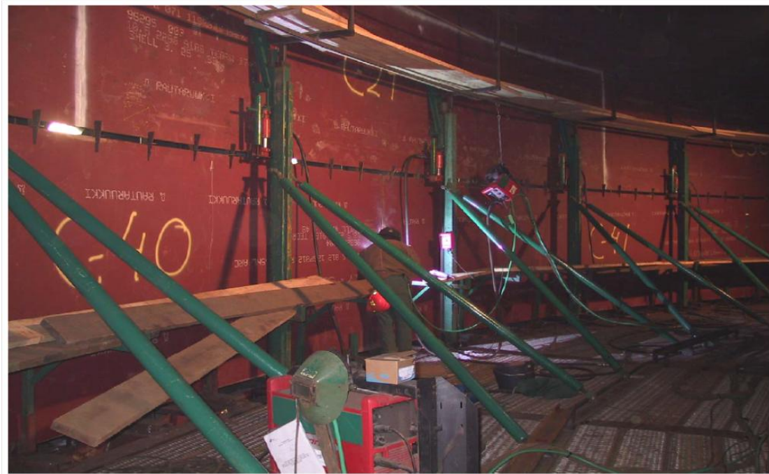
Εικόνα 5.34: Εργασίες συγκόλλησης των προσχηματισμένων πλακών χάλυβα της δεξαμενής αποθήκευσης (Tengborg, 2006).
