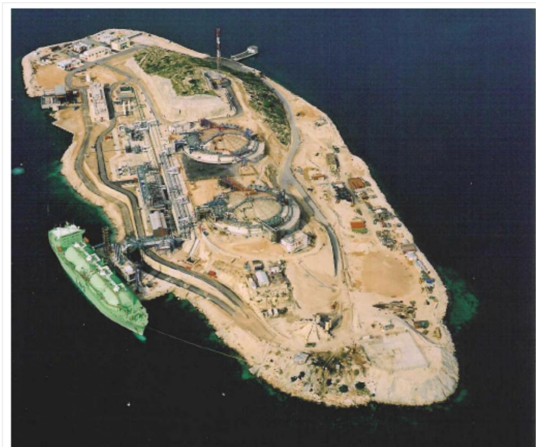
Εικόνα 4.6: Τερματικός σταθμός LNG Ρεβυθούσας (Καρόνης, 2007).
