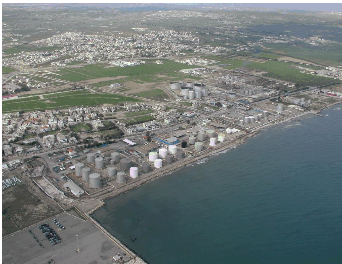
Εικόνα 1.5: Ιδιόκτητες εγκαταστάσεις εισαγωγής, αποθήκευσης και διανομής πετρελαιοειδών στο τερματικό καυσίμων της Λάρνακας (Υπηρεσία Ενέργειας, 2012).
