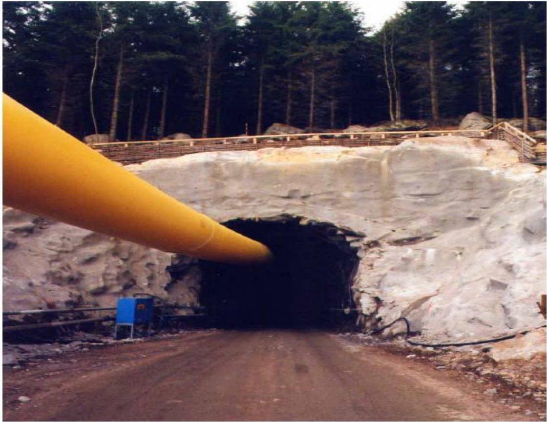
Εικόνα 5.31: Είσοδος σήραγγας (Tengborg, 2006).
