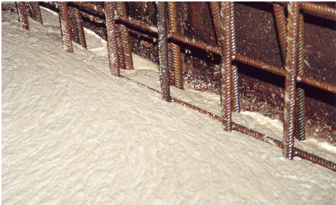
Εικόνες 5.35 – 5.36: Η τοποθέτηση του σκυροδέματος μεταξύ της μεμβράνης χάλυβα και του βράχου του σπηλαίου (Tengborg, 2006).
