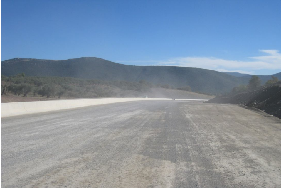
Εικόνα 5.2: Ο υπό κατασκευή άξονας (επιφάνεια της βάσης)
