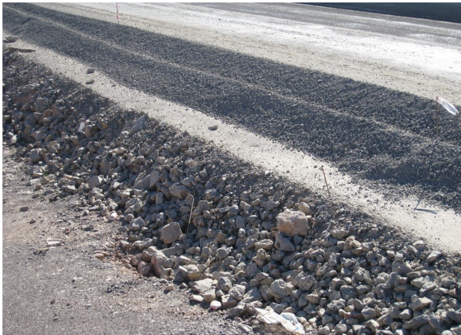
Εικόνα 5.3: Συμπυκνωμένο ασύνδετο αμμοχάλικο
