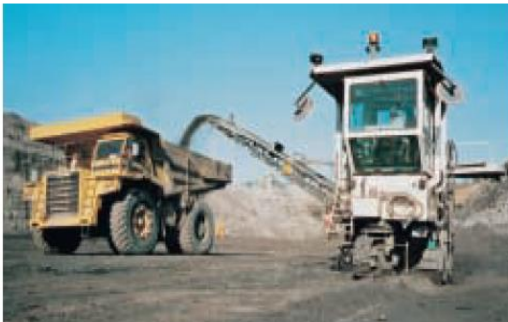
Εικόνα 13. Φόρτωση του εξορυγμένου υλικού πλευρικά του Surface Miner (Manual Wirtgen Gmbh, 2010) .
