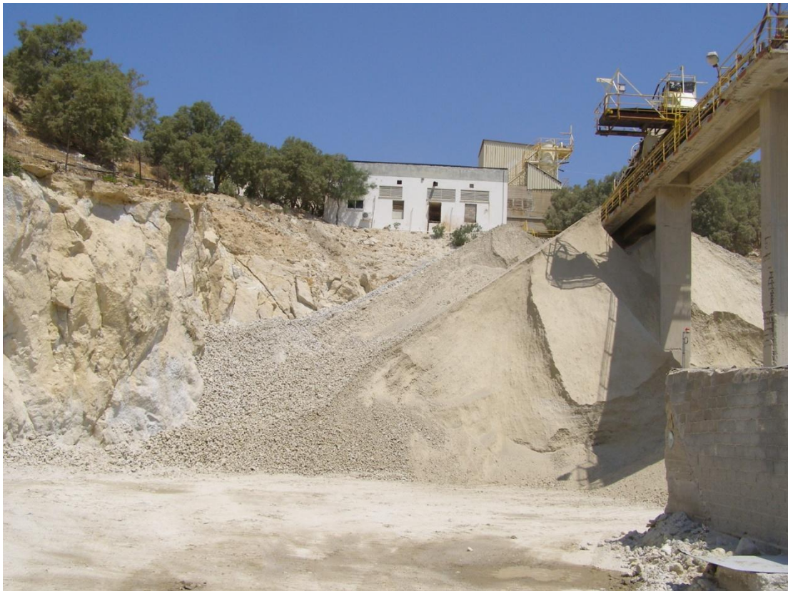
Εικόνα 6. Υπαίθριος αποθηκευτικός χώρος.
