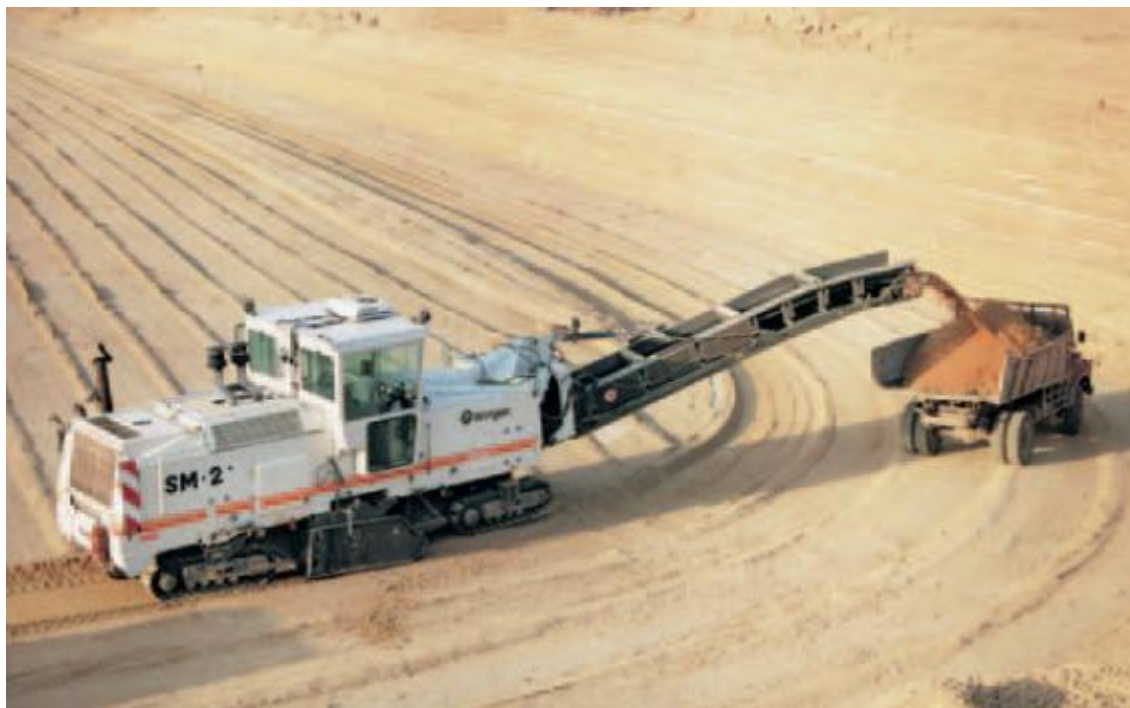
Εικόνα 12. Surface Miner κατά τη διαδικασία εξόρυξης και φόρτωσης του πετρώματος.
