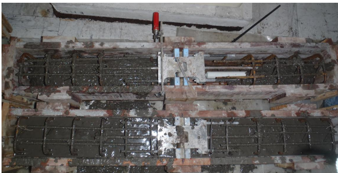
Σχήμα 3-5: Δοκίμια κατά τη σκυροδέτηση
