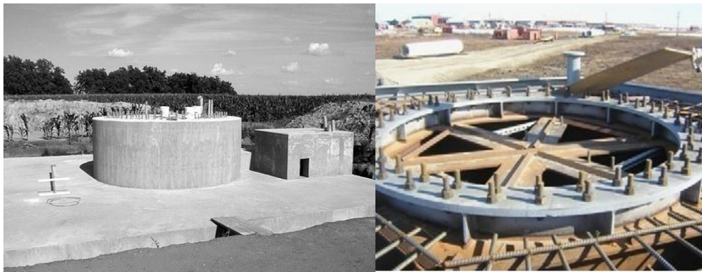
Εικόνα 4.1 Θεμελίωση με πέδιλο-πλάκα
