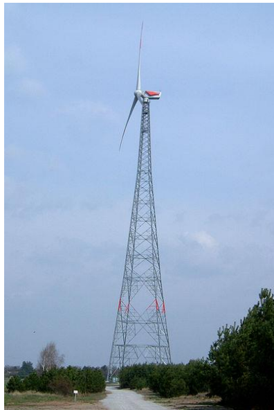
Εικόνα 2.9 Ο ψηλότερος δικτυωτός πύργος στο Laasow (Brandenburg)
