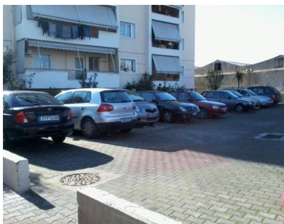
Εικόνα 25 – Ένας από τους χώρους στάθμευσης του συγκροτήματος "ΤΑΥΡΟΣ Ι"
