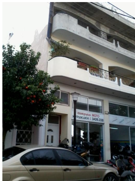
Εικόνα 45 – Συνεργείο, κατοικία και υπό κατασκευή όροφος
