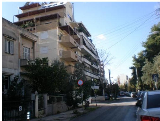
Εικόνα 18 - Κατοικίες διάφορων ηλικιών
