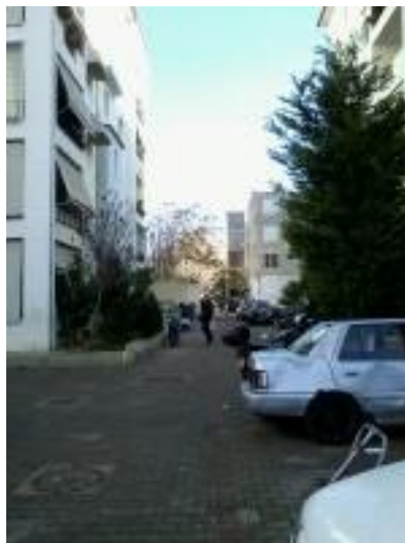
Εικόνα 82- Κοινόχρηστος χώρος συγκροτήματος «ΤΑΥΡΟΣ Ι»
