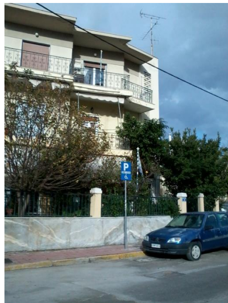
Εικόνα 54 - Πολυκατοικία με αυλόγυρο και θέσεις στάθμευσης
