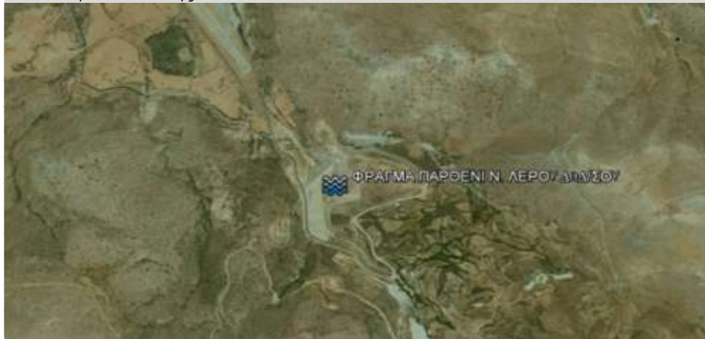
Πίνακας 18. Φράγμα “Παρθένι” Ν.Λέρου
