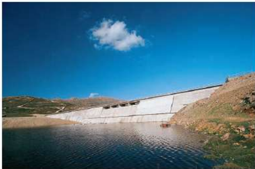
Εικόνα 16. Φράγμα Μαραθιά νήσου Μυκόνου
