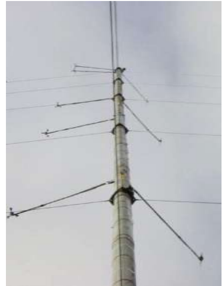
Εικόνα 31. Τυπικός σωληνωτός ανεμολογικός ιστός
