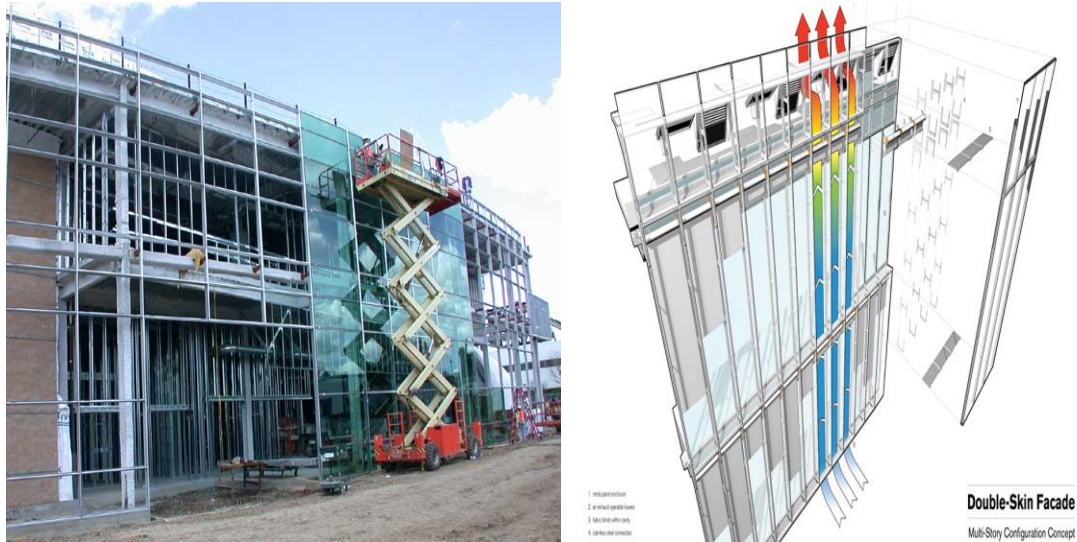
Εικ.6.14: Τοποθέτηση διπλοκέλυφης πρόσοψης
