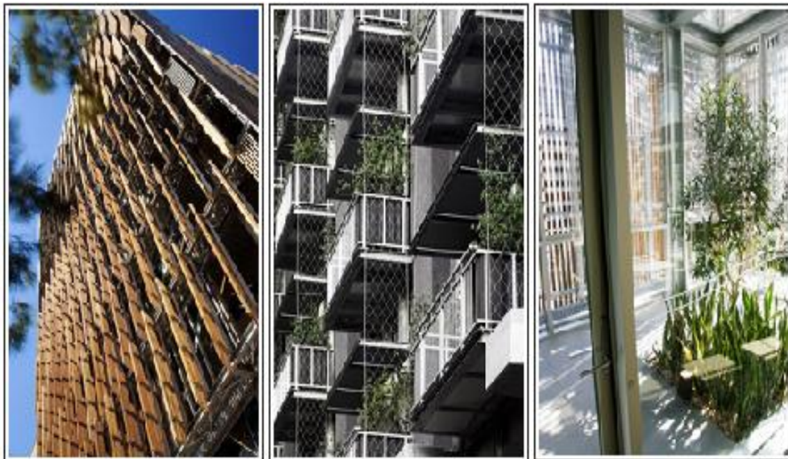
Εικ.6.11: Δυτική και βορινή όψη του CH2 και εσωτερικό αίθριο.
