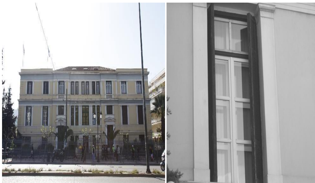
Εικ.4.10: Βορειοδυτική όψη και λεπτομέρεια ανοίγματος.
