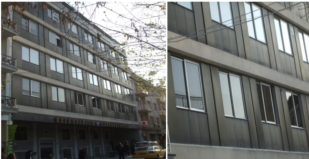
Εικ.4.16: Βόρεια όψη και λεπτομέρειες ανοιγμάτων
