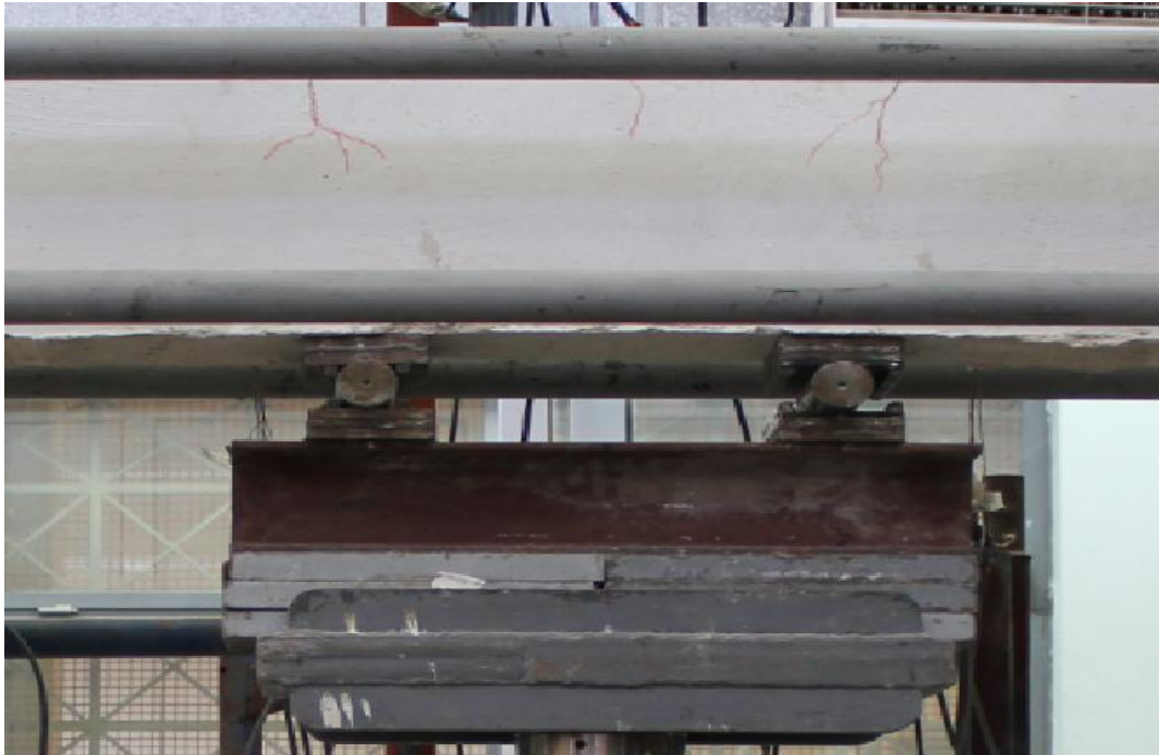
ΕΙΚΟΝΑ 20 Διαφοροποίηση εύρους της πρώτης οικογένειας ρωγμών και εμφάνιση νέας ρωγμής στην περιοχή της μέγιστης ροπής στο δοκίμιο A2-M280
