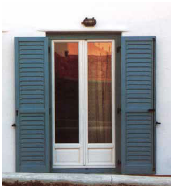
Εικ. 2.2.3.2.1: Το μεσογειακό παντζούρι εμποδίζει την είσοδο τόσο της άμεσης όσο και της διάχυτης ακτινοβολίας (πηγή: Δράκου Κατερίνα, “Σχεδιασμός συστήματος φυσικού και τεχνητού φωτισμού σε θάλαμο νοσηλείας νοσοκομείων”, Ακαδημαϊκό έτος: 2007-2008, Βόλος, σελ. 12)
