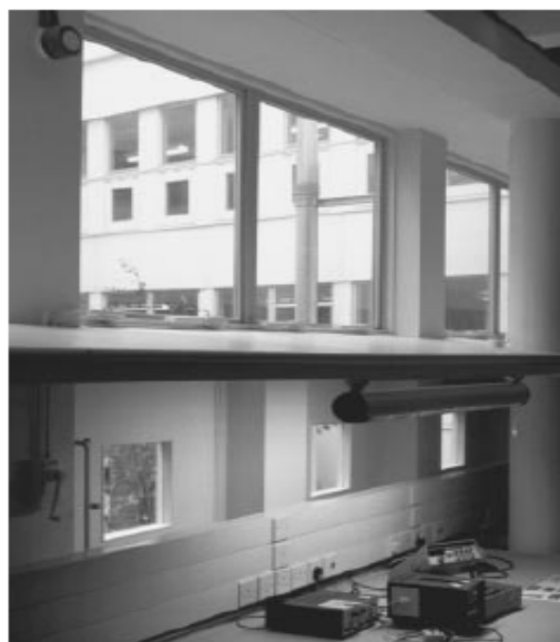
Εικ. 7.1.3.1. Ετερογενής σχεδιασμός παραθύρου: διαφορετικά συστήματα μπορούν να εφαρμοστούν σε διαφορετικά σημεία του παραθύρου ή παρόμοια συστήματα μπορούν να λειτουργούν ξεχωριστά σε διαφορετικά σημεία του παραθύρου (πηγή: Δράκου Κατερίνα, «Σχεδιασμός συστήματος φυσικού και τεχνητού φωτισμού σε θάλαμο νοσηλείας νοσοκομείων», Ακαδημαϊκό έτος: 2007-2008, Βόλος)
