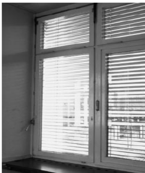
Εικ. 7.1.3.1. Ετερογενής σχεδιασμός παραθύρου: διαφορετικά συστήματα μπορούν να εφαρμοστούν σε διαφορετικά σημεία του παραθύρου ή παρόμοια συστήματα μπορούν να λειτουργούν ξεχωριστά σε διαφορετικά σημεία του παραθύρου (πηγή: Δράκου Κατερίνα, «Σχεδιασμός συστήματος φυσικού και τεχνητού φωτισμού σε θάλαμο νοσηλείας νοσοκομείων», Ακαδημαϊκό έτος: 2007-2008, Βόλος)
