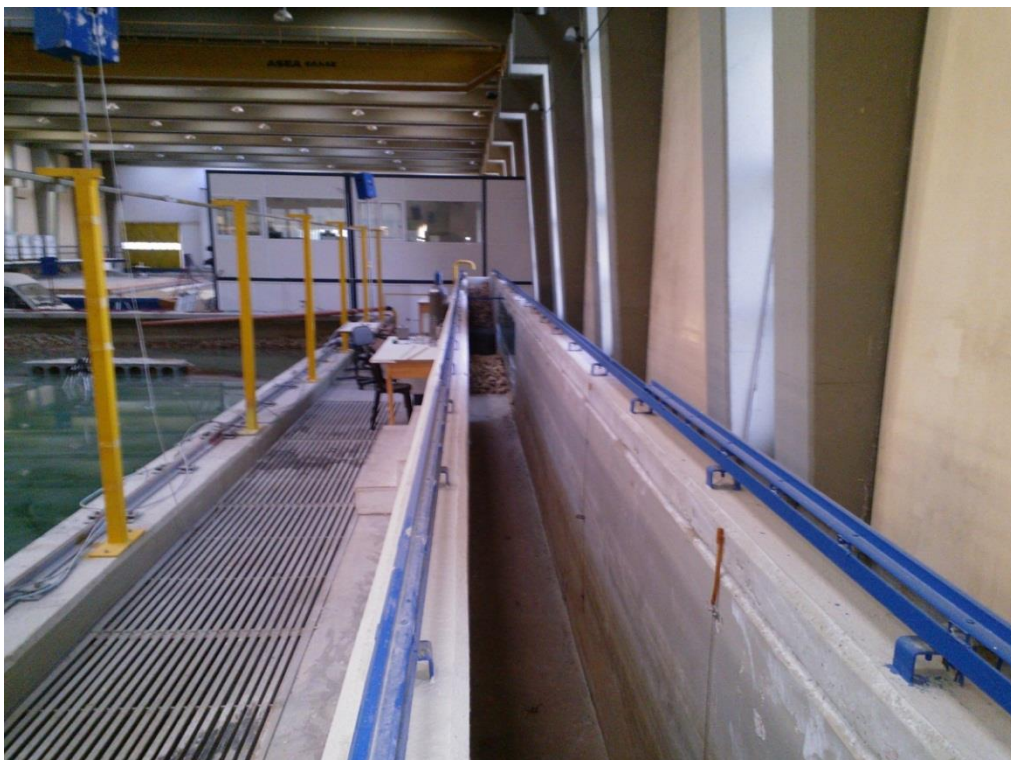
Φωτ. 8 – Το εσωτερικό της πειραματικής διώρυγας. Στο βάθος φαίνεται ο ύφαλος κυματοθραύστης και λίγο μετά ο αποσβεστήρας κυματικής ενέργειας στο άκρο της διώρυγας.
