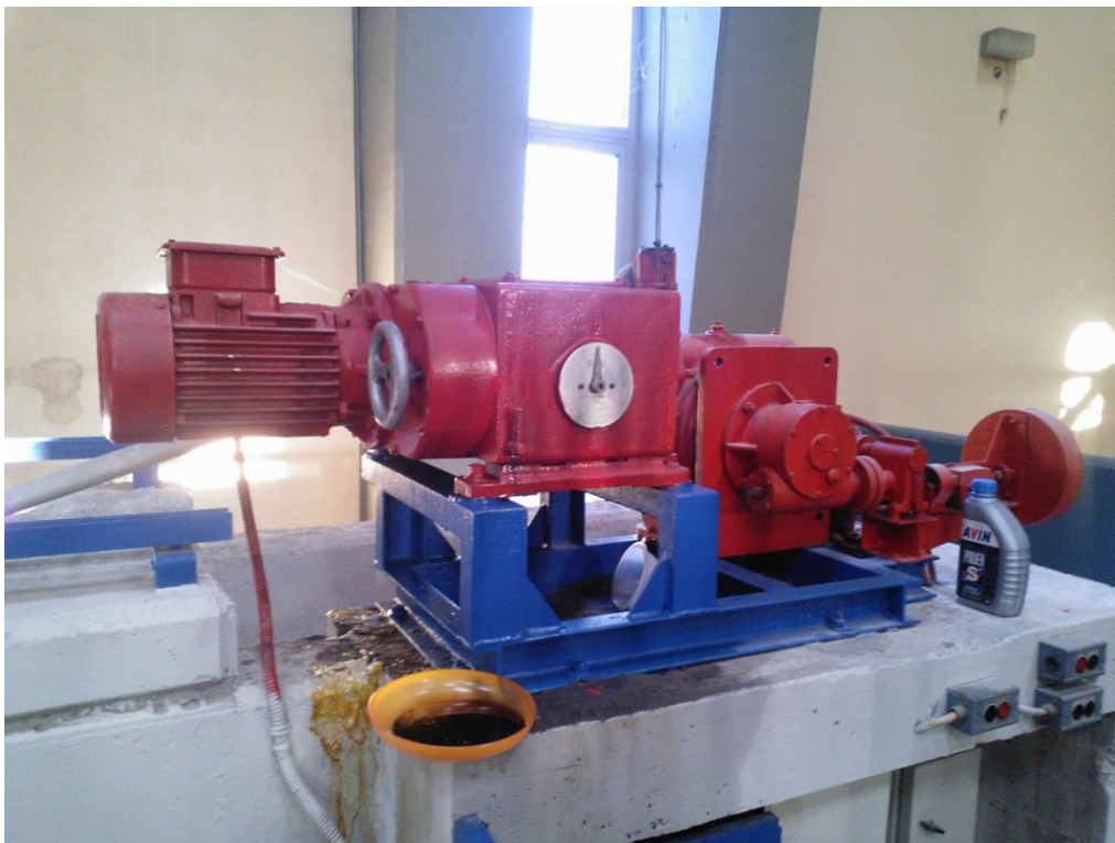
Φωτ. 2 – Η κυματογεννήτρια της διάρρυγας πάνω σε βάθρο από σκυρόδεμα.
