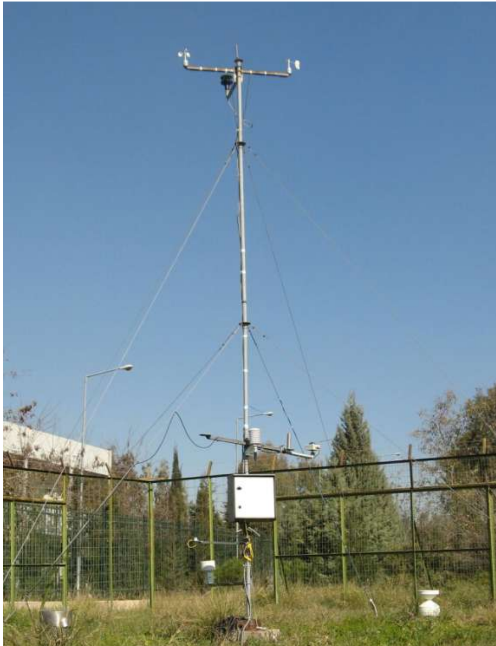
Εικόνα 4.7: Μετεωρολογικός σταθμός Ε.Μ.Π. [2].
