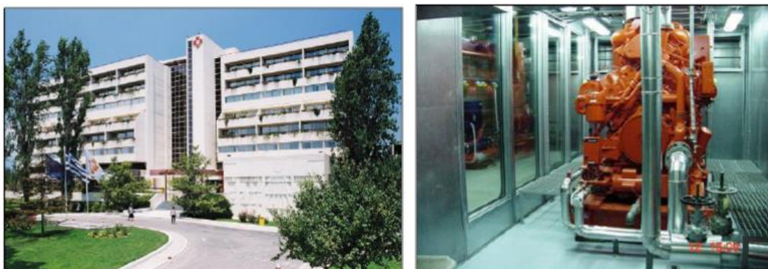
Εικόνα 1.8: Εφαρμογή Συμπαραγωγής στο νοσοκομείο ΜΗΤΕΡΑ, Ηλεκτρική Ισχύς: 490kw, Θερμική Ισχύς:890kw, Ψυκτική Ισχύς: 180 RT [27]
