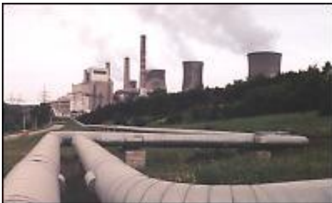
Εικόνα 1.7: Ατμοηλεκτρικός σταθμός της Δ.Ε.Η. στην Πτολεμαΐδα που συμπαράγει ηλεκτρισμό και θερμότητα για τη τηλεθέρμανση της πόλης [5]
