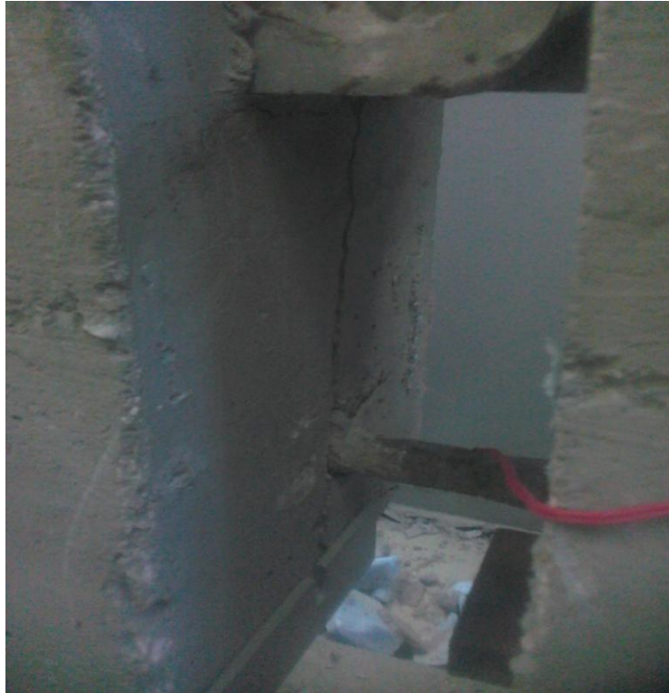
Σχήμα 3-14: Αστοχία δοκού
