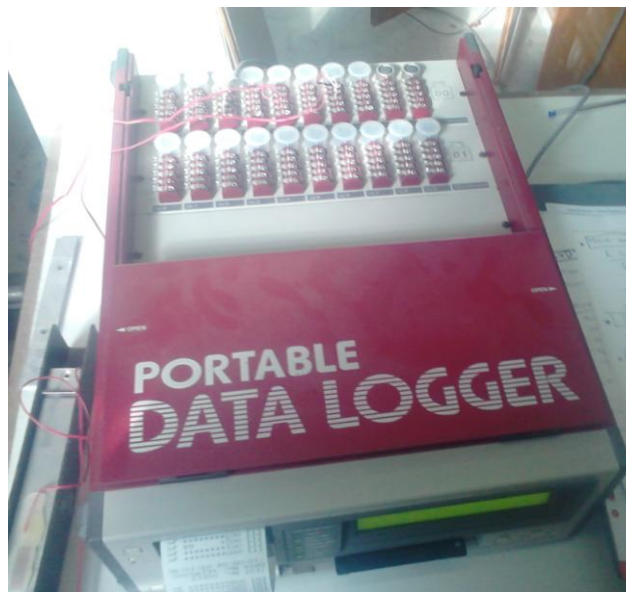
Σχήμα 3-10: Σύστημα καταγραφής μετρήσεων των ηλεκτρομηκυσιομέτρων
