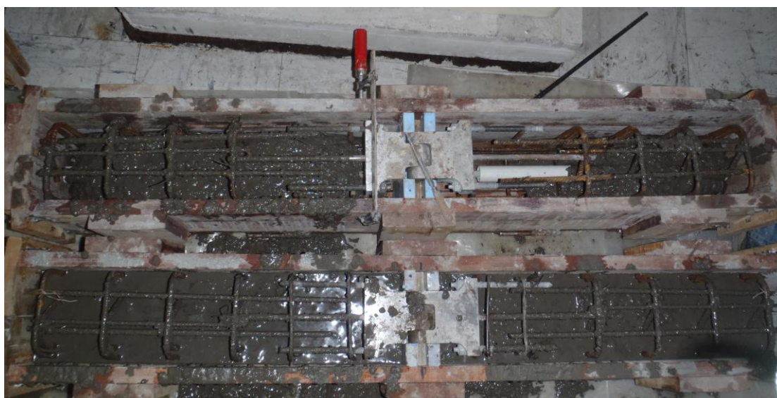
Σχήμα 3-5: Δοκίμια κατά τη σκυροδέτηση
