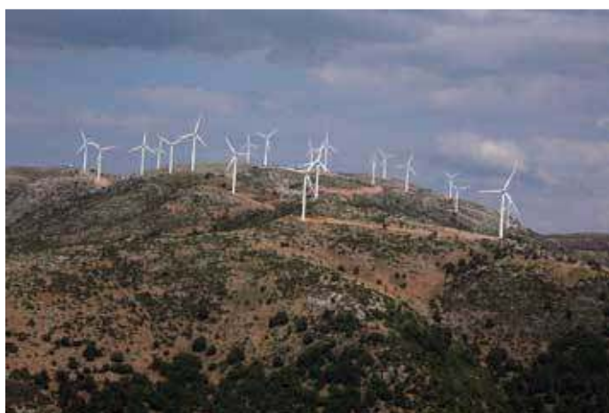
Φωτογραφία 1.2: Αιολικό πάρκο στη Μαγνησία
