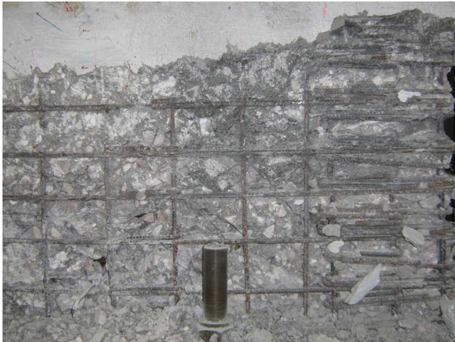
Φωτογραφία 8 Εικόνα στην οποία είναι εμφανής η μη ύπαρξη μονολιθικότητας (β)
