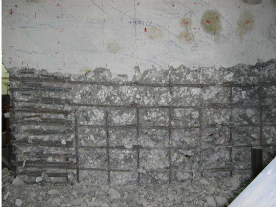
Φωτογραφία 7. Εικόνα στην οποία είναι εμφανής η μη ύπαρξη μονολιθικότητας (α)
