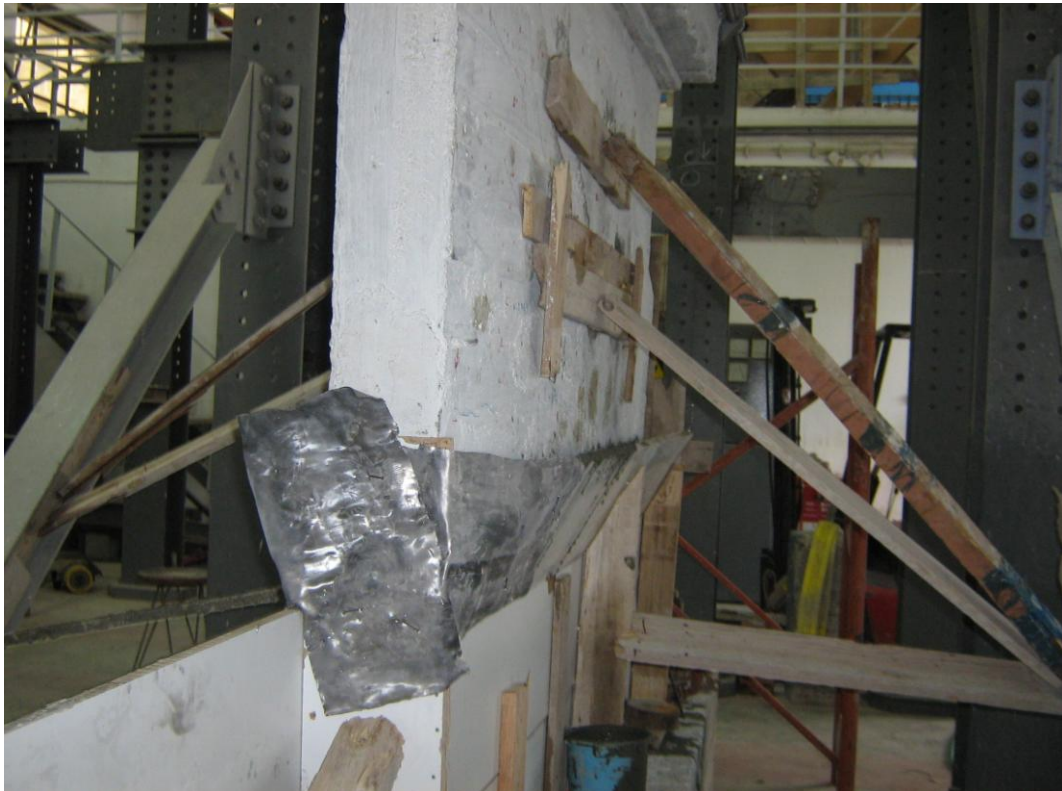
Φωτογραφία 14. Καλούπι τοιχίου για την αποκατάσταση της επισκευής
