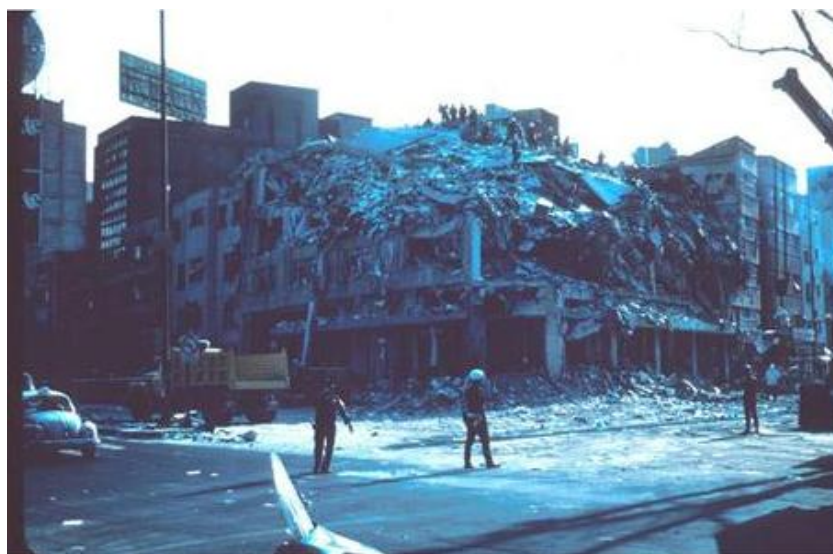
Εικόνα 1.4 – Μεξικό 1985 – Κατάρρευση του ανώτερου τμήματος 8-όροφου κτιρίου λόγω του φαινομένου
