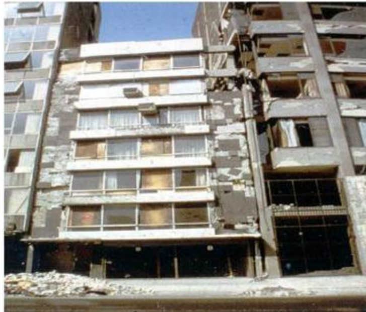
Εικόνα 1.1 - Μεξικό 1985 – Κρούση λόγω σεισμού όμορων κτιρίων και βλάβες
