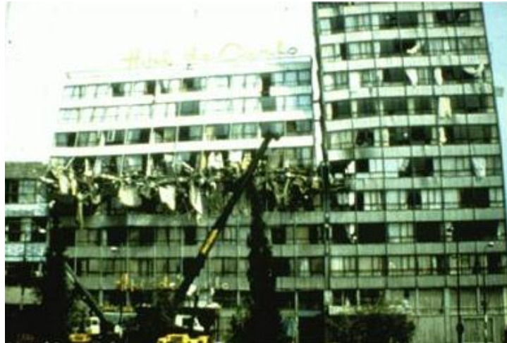
Εικόνα 1.5 – Μεξικό 1985 – Κατάρρευση του μεσαίου ορόφου του κτιρίου Hotel de Carlo στην πόλη του Μεξικό λόγω της κρούσης με τα γειτονικά σε επαφή κτίρια
