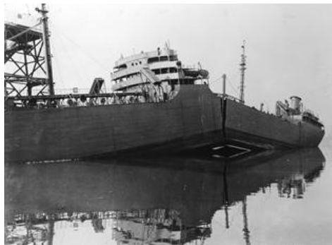
Σχήμα 1.3: Ολική αστοχία τάνκερ τύπου 530T2 το 1943 [9]
