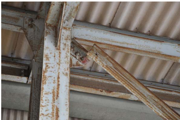
Σχήμα 1.8: Αστοχίες συνδέσεων κατά το σεισμό Tohoku στην Ιαπωνία το 2011 [15]
