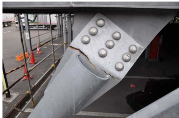
Σχήμα 1.8: Αστοχίες συνδέσεων κατά το σεισμό Tohoku στην Ιαπωνία το 2011 [15]
