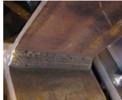
Σχήμα 5.10: Λεπτομέρεια εξωραφών για την περίπτωση δοκών διατομής HEA300
