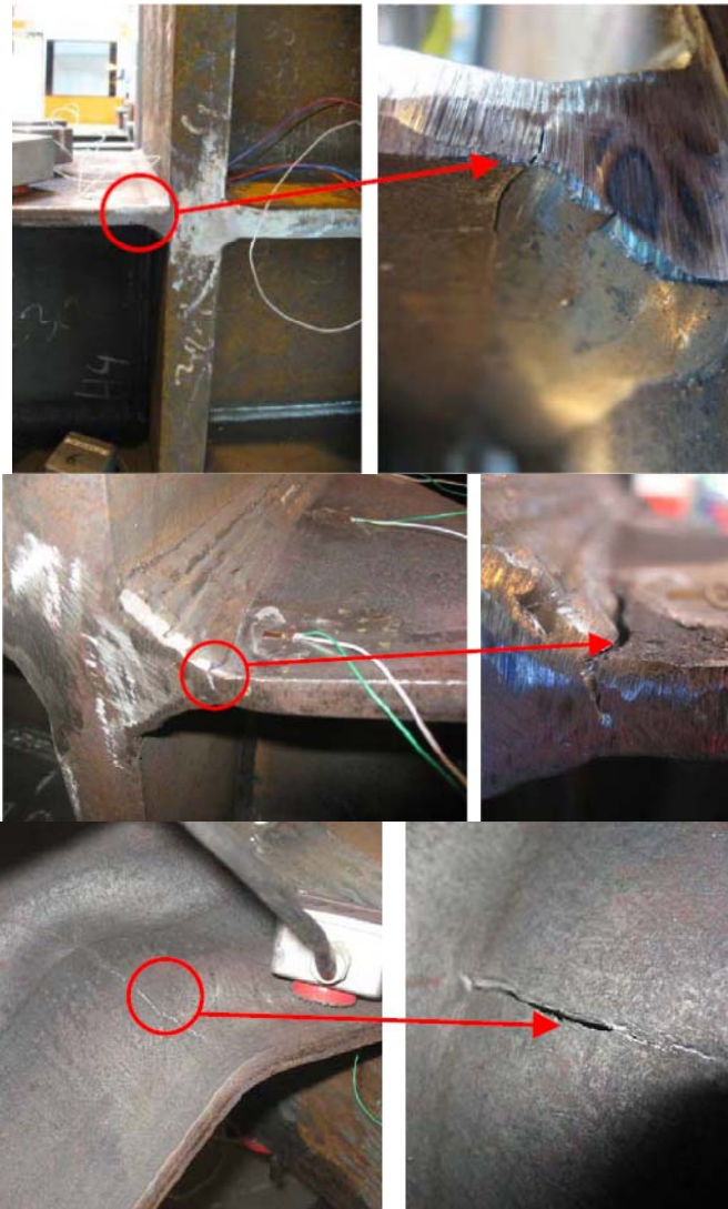
Σχήμα 7.19: Τύποι παρατηρούμενων ρωγμών κατά τη διάρκεια των ανακυκλιζόμενων πειραμάτων
