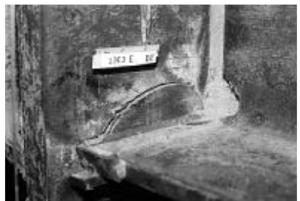
Σχήμα 4.3: Ψαθυρής μορφής αστοχίες από το σεισμό του Northridge σε πλαίσια ροπής στη συγκόλληση δοκού-υποστυλώματος (αριστερά) και στο πέλμα του υποστυλώματος (δεξιά) [13]
