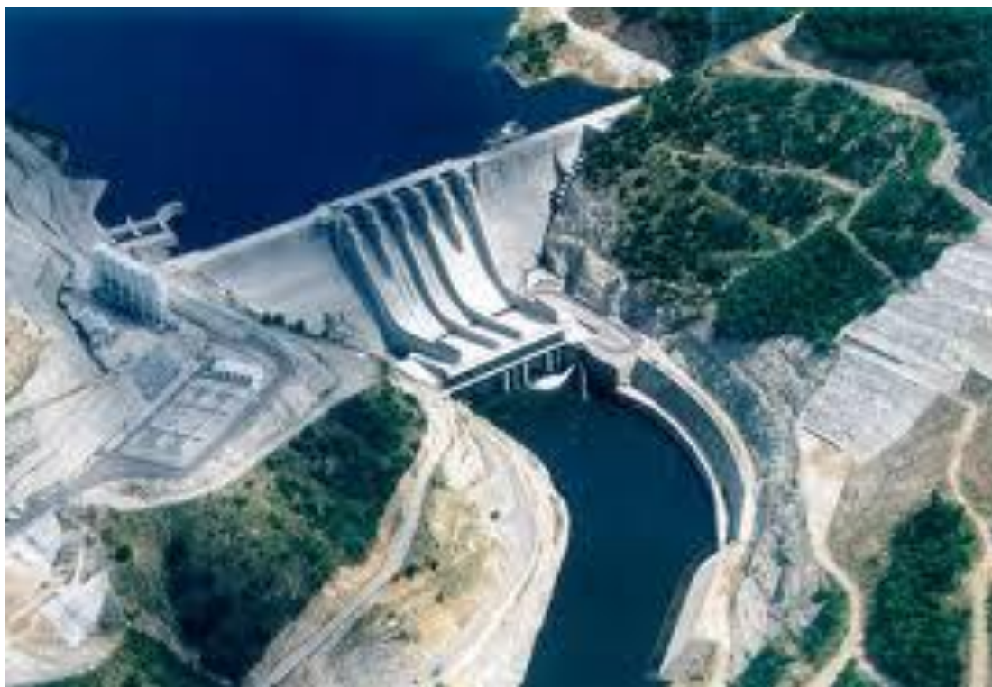
Σχ. 5-9: Το φράγμα της Πλατανόβρυσης ( www.airdynamics.gr )
