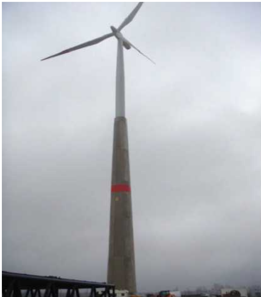
Σχήμα 1.13 : Υβριδικός πύργος σκυροδέματος/χάλυβα
