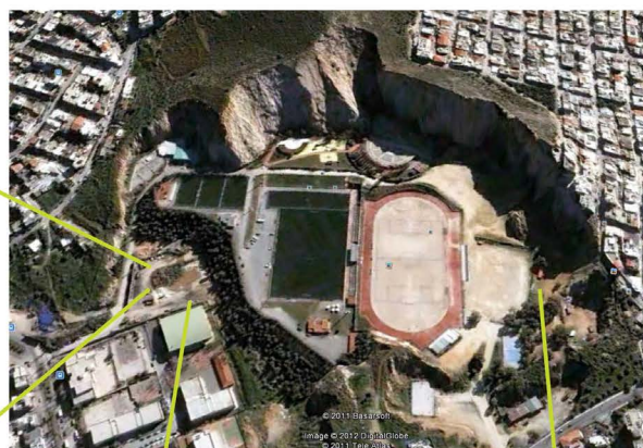
Υφιστάμενη κατάσταση του πρώην λατομείου Εργάνης
