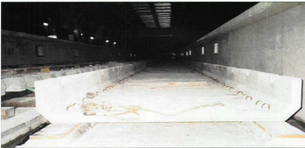
Εικόνα 4.6 Πλωτή πλάκα με συνεχείς λωρίδες ελαστομερών.
