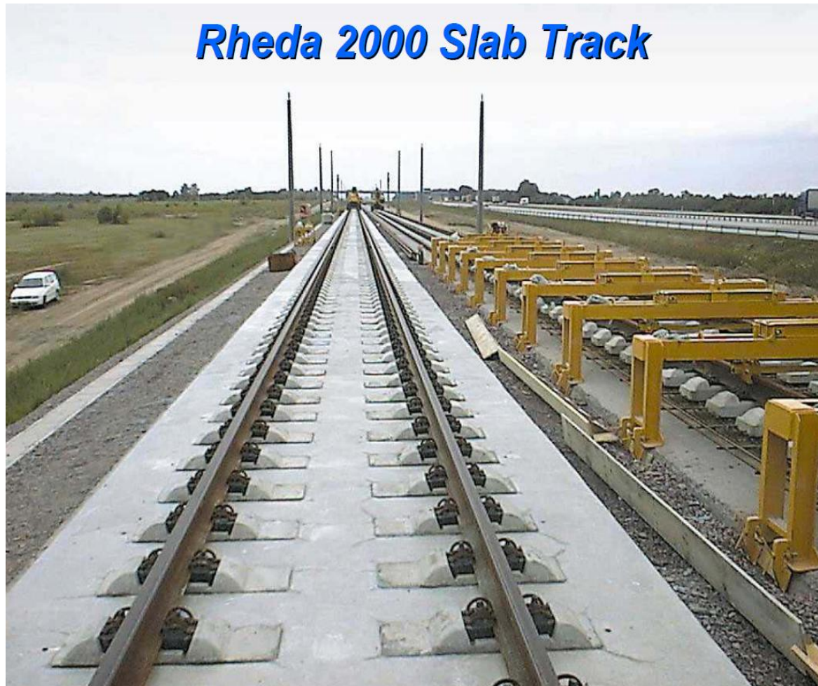
Εικόνα 3.1 Σύστημα σταθερής επιδομής Rheda 2000.
