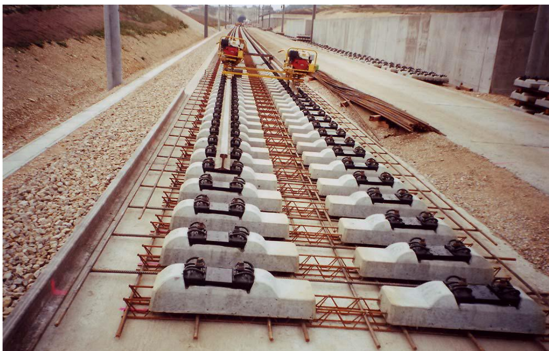
Εικόνα 3.2 Διμερείς στρωτήρες B355.
