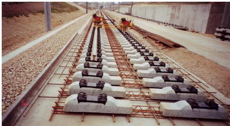
Εικόνα 2.2 Σύστημα σταθερής επιδομής RHEDA 2000.
