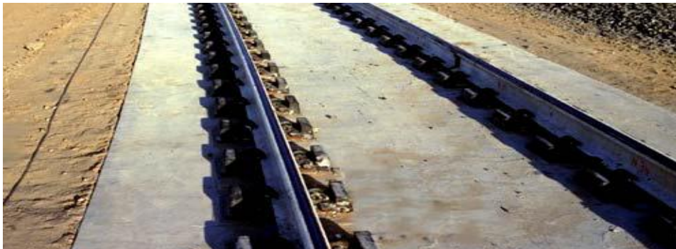
Εικόνα 2.3 Σύστημα σταθερής επιδομής με απευθείας στερέωση.
