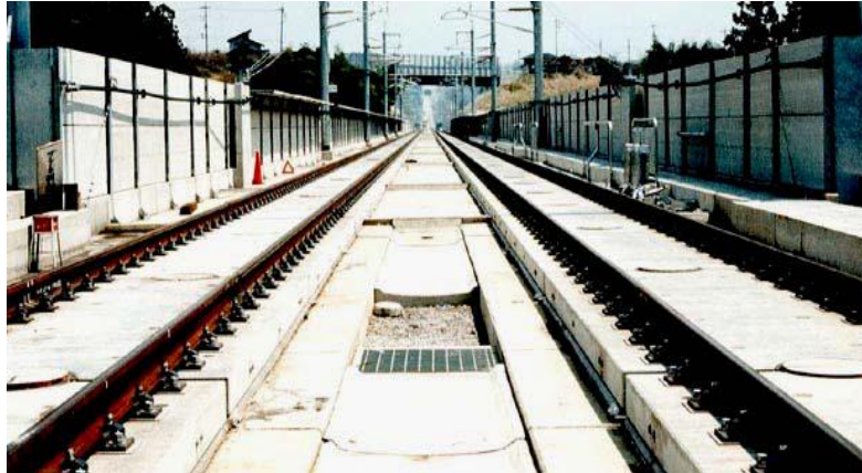
Εικόνα 2.4 Σύστημα σταθερής επιδομής Shinkansen.
