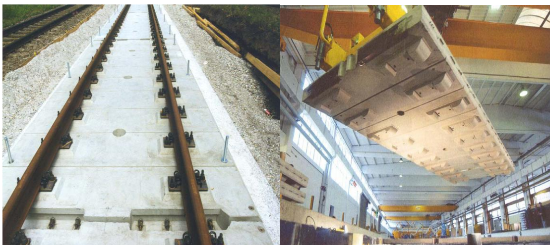
Εικόνα 2.5 Σύστημα σταθερής επιδομής BogI. [1]
