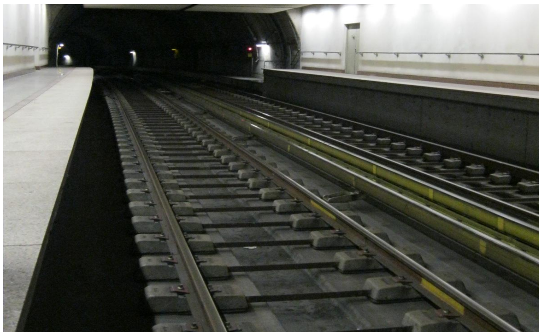
Εικόνα 4.3 Σταθερή επιδομή Stedef στο Αττικό Μετρό.
