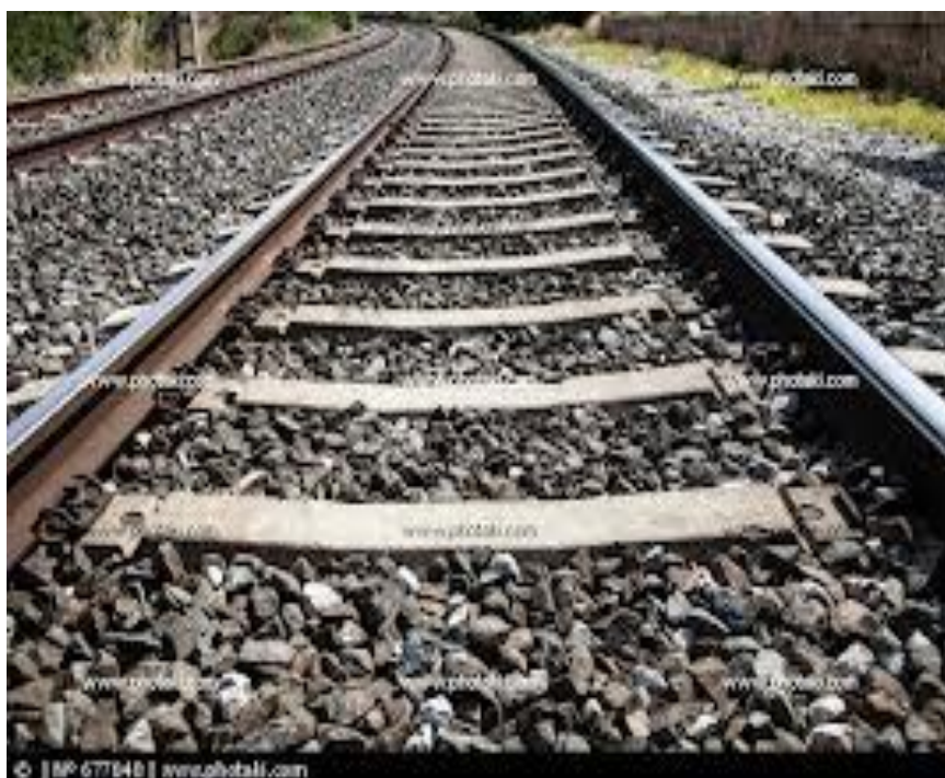
Εικόνα 2.1 Επιδομή με έρμα.
