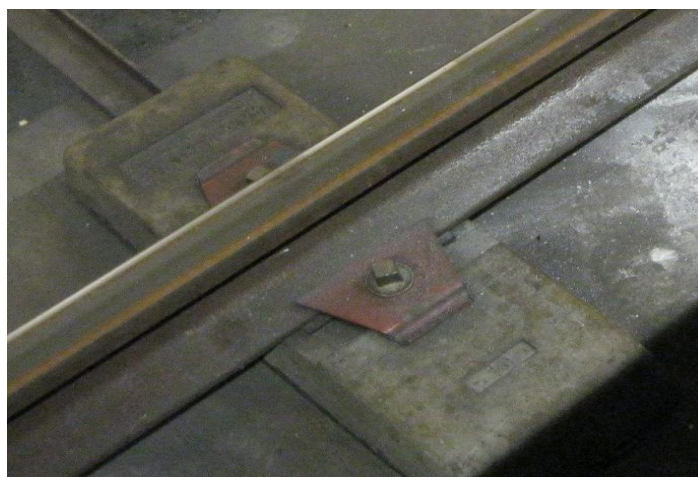
Εικόνα 4.2 Σύνδεσμος σταθερής επιδομής Nabla.
