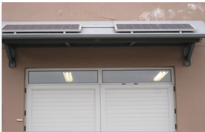
Εικόνα 2.2.3: Φ/β πλαίσια πειραματικής διάταξης.
