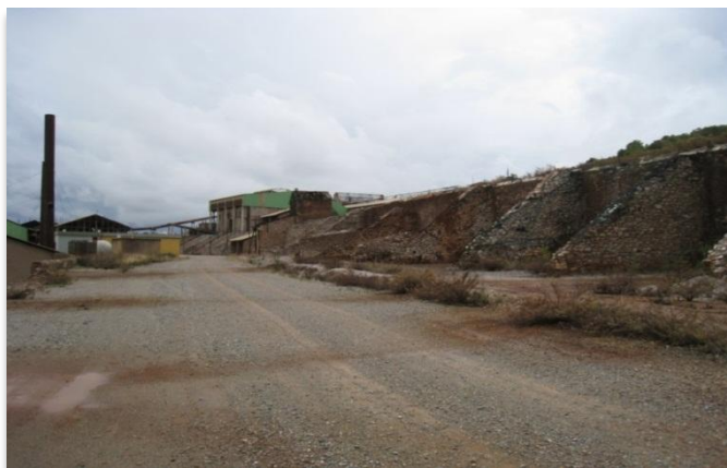
Εικόνα 2.2.1: Τεχνολογικό Πολιτιστικό Πάρκο Λαυρίου. Τόπος εγκατάστασης των φ/β πλαισίων.
