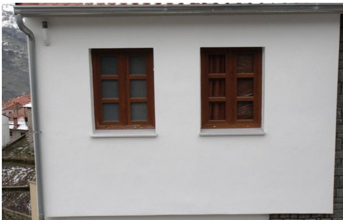
Εικόνα Π.1. Άποψη τμήματος πρόσοψης κατοικίας κτισμένης μετά το 1990
