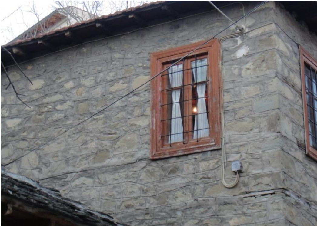
Εικόνα Π.3. Άποψη κατοικίας, κτισμένης με φέρουσα λιθοδομή
