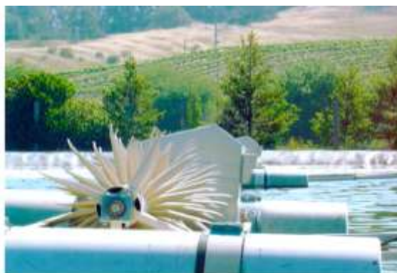
Φωτογραφία 3.5: Οι αεριστήρες τύπου βούρτσας
