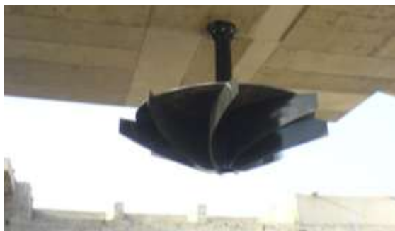
Φωτογραφία 3.2: Ο επιφανειακός περιστρεφόμενος αεριστήρας σταθερού άξονα
