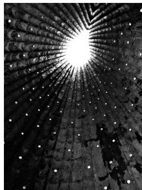
Εικ. 52: Το φωτιστικό άνοιγμα της οροφής. Διακρίνονται οι κυκλικές οπές που επιτρέπουν την είσοδο του φωτός.
