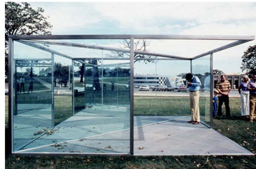
Εικ. 31: Ο τρόπος με τον οποίο έχουν τοποθετηθεί τα πάνελα πλήρωσης δημιουργεί σύγχυση μεταξύ του αντικατοπτριζόμενου και του πραγματικού περιβάλλοντος
