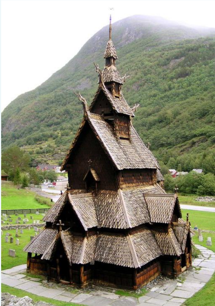
εικόνα 18: Ξύλινη νορβηγική εκκλησία «Stavkirke» 13ος αιώνας. (Πηγή: www.wikipedia.org )
