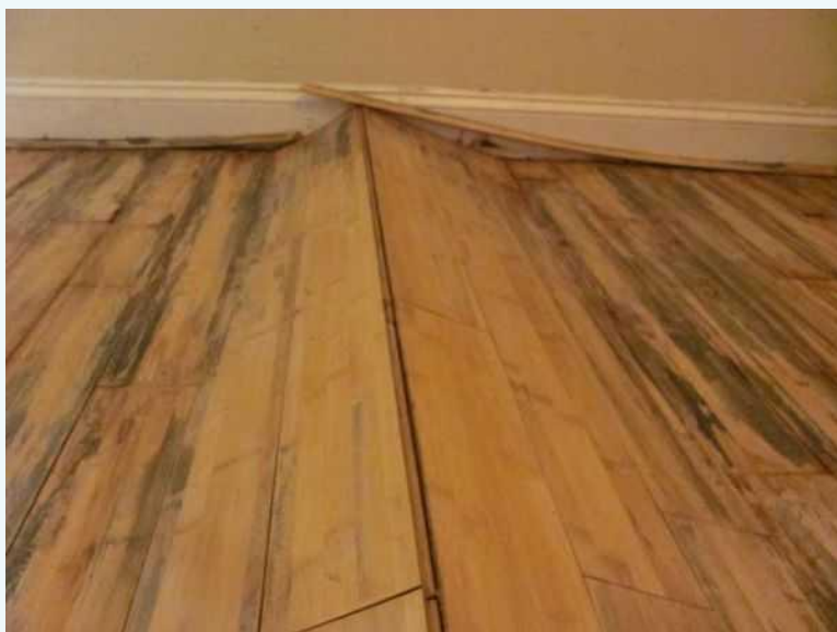
εικόνα 3: Καταστροφή ξύλινου δαπέδου από υγρασία. (Πηγή: http://andrewscarpetcleaning.com )
