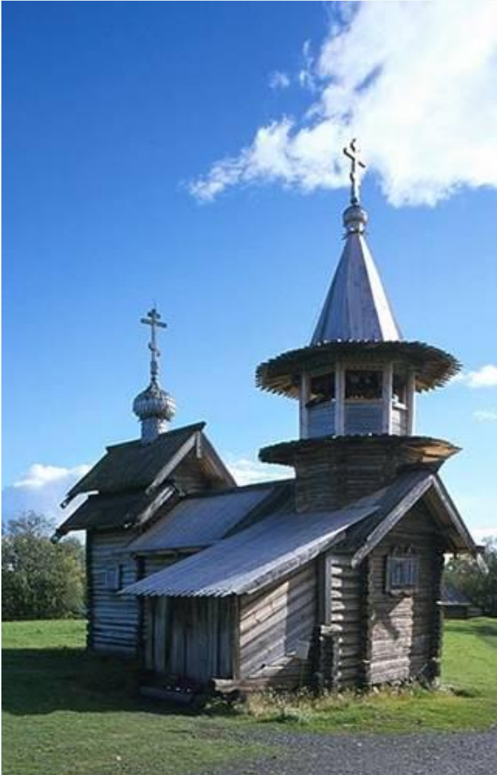
εικόνα 16: Ρώσικη εκκλησία στο νησί Kizhi - 14ος αι. (Πηγή: http://architecture.about.com )
