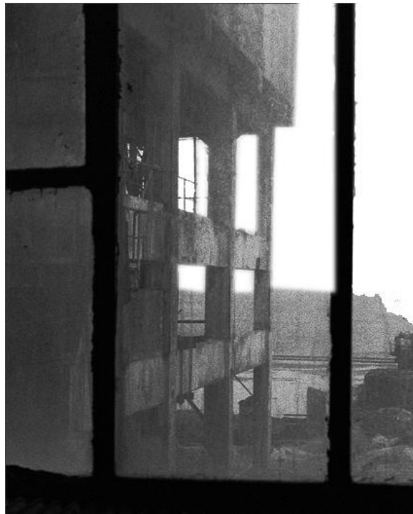
Φωτογραφία από το ερειπωμένο εργοστάσιο λιπασμάτων στον Πειραιά. Πηγή: http://www.dpgr.gr/forum/index.php?topic=5357.0
