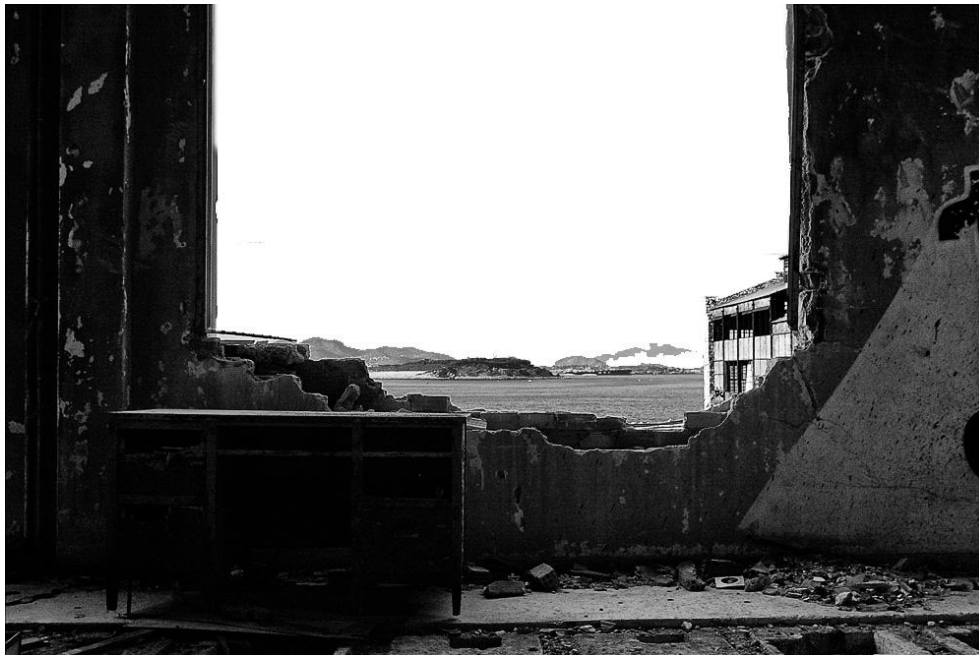
Φωτογραφία από το ερειπωμένο εργοστάσιο λιπασμάτων στον Πειραιά. Πηγή: http://www.dpgr.gr/forum/index.php?topic=5357.0
