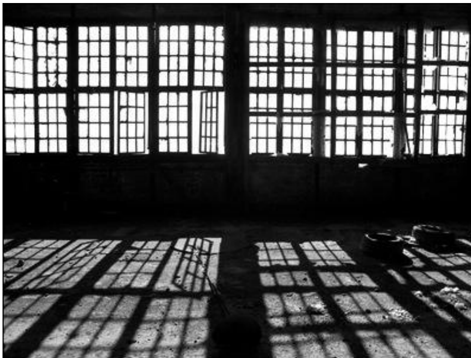
Φωτογραφία από το ερειπωμένο εργοστάσιο λιπασμάτων στον Πειραιά. Πηγή: http://www.dpgr.gr/forum/index.php?topic=5357.0
