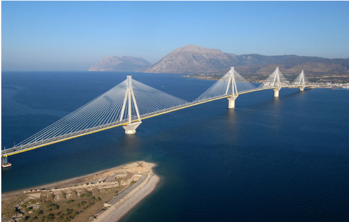
Εικόνα 4. Γέφυρα Ρίου - Αντιρρίου
