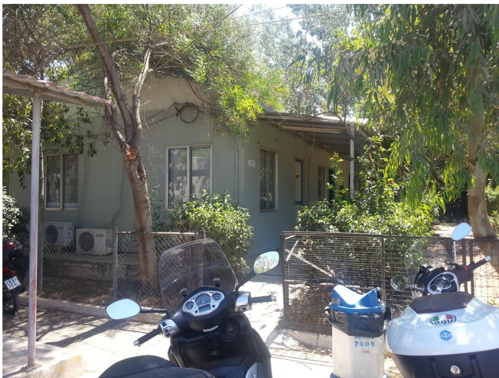
Εικόνα 43, Προκατασκευασμένη μεταλλική εγκατάσταση που στεγάζει τα γραφεία της Διεύθυνσης
