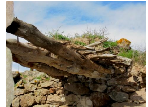
99. Φέρουσα κατασκευή δώματος
