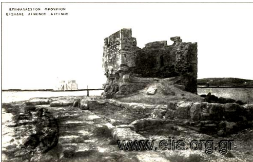
78. Επιθαλάσσιο φρούριο στην είσοδο του λιμανιού
