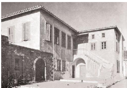
56, 57 Το Κυβερνείο πριν και μετά την επισκευή
