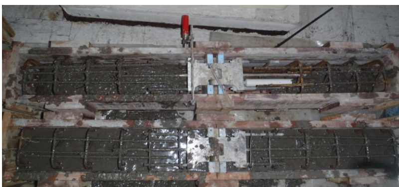
Σχήμα 3.6 Δοκίμια κατά τη σκυροδέτηση
