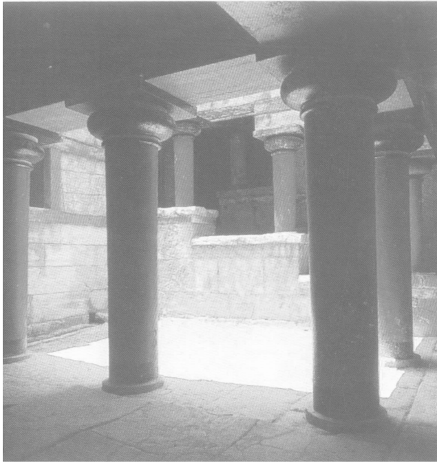
54_ Το αίθριο στα ανάκτορα της Κνωσού. Μέσω αυτού το φως εισάγεται στο υπόγειο.
