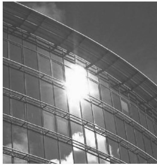
9_ Θάμβωση από την ανάκλαση του φωτός στους υαλοπίνακες καθρέφτες.
