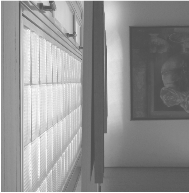
25_ Πανέλα έχουν τοποθετηθεί μπροστά από τους ναλότοιχους.
