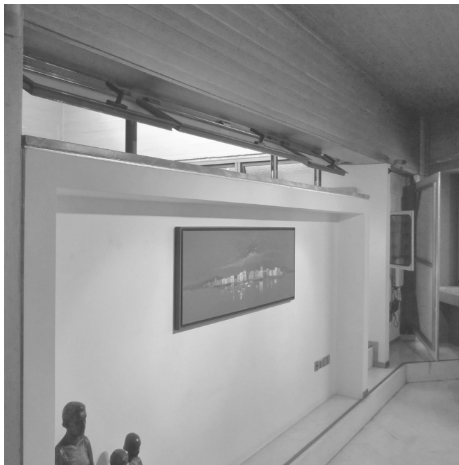
24_Ανοίγματα προς τον εσωτερικό φωταγωγό που εξασφαλίζουν φυσικό αερισμό
