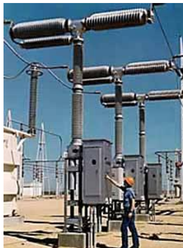
Εικόνα 1.15: Διακόπτες ισχύος τύπου «live-tank» [8]
