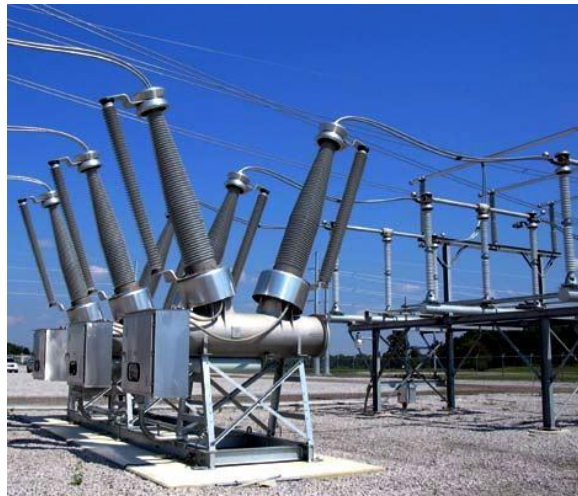
Εικόνα 1.14: Διακόπτες ισχύος τύπου «dead-tank» [7]
