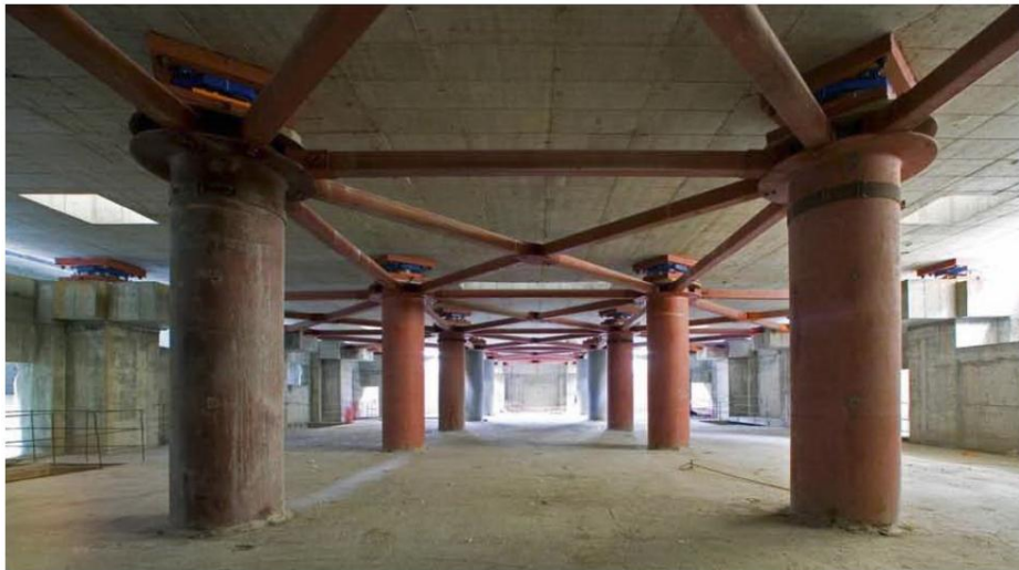
Εικόνα 4.1. Ωνάσειος στέγη (σύστημα 46 εφεδράνων τριβής-ολίσθησης).
