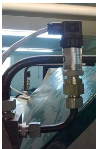
Σχήμα 4.14 Ο μεταλλάκτης πίεσης (D)
