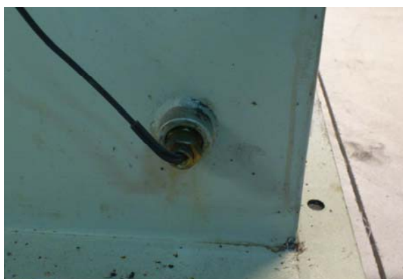
Σχήμα 3.21 Θερμοστοιχείο μέτρησης θερμοκρασίας υδραυλικού ρευστού
