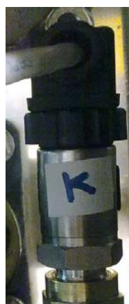
Σχήμα 4.19 Ο μεταλλάκτης πίεσης (K)
