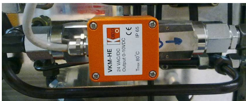
Σχήμα 4.5 Το παροχόμετρο (B)
