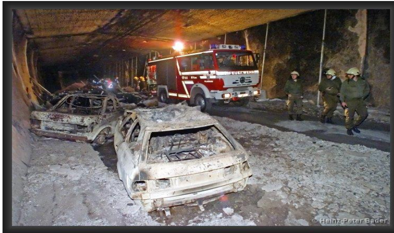
Εικόνα 3.9 Το εσωτερικό της σήραγγας του Tauern μετά την καταστροφή (Tauern tunnel accident 2012)
