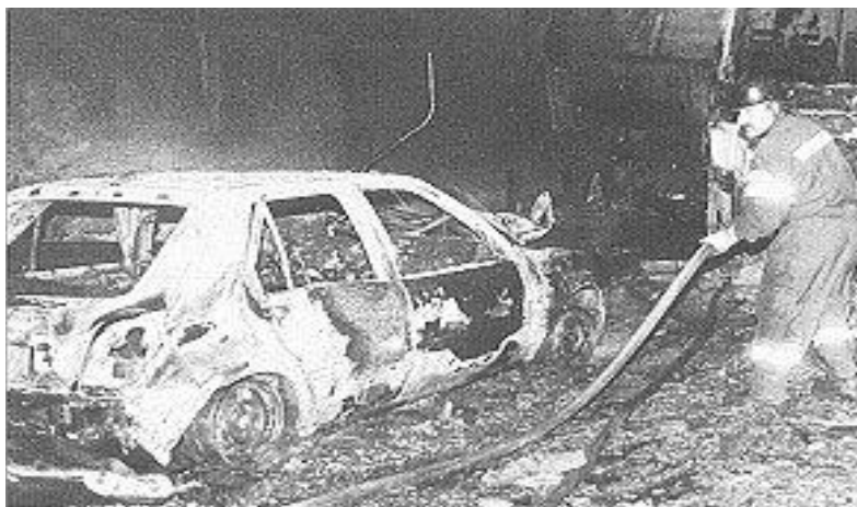
Εικόνα 23 Το εσωτερικό της σήραγγας μετά την κατάσβεση της φωτιάς (Masellis et al. 1997)
