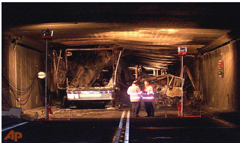
Εικόνα 3.13 Συνεργεία διάσωσης στο εσωτερικό της σήραγγας μετά την κατάσβεση της φωτιάς (St. Gotthard tunnel accident 2007)
