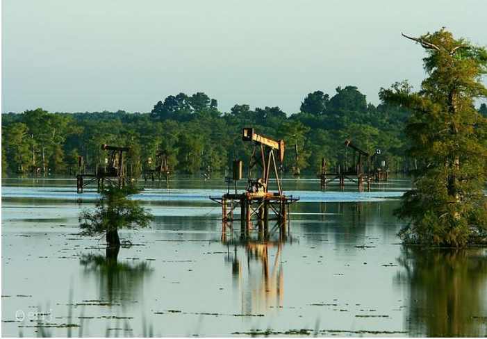
Εικόνα 1.1: Πλατφόρμες με ξύλινους πασσάλους στη Λίμνη Caddo, Texas. (Πηγή: Louisiana Collection, State Library of Louisiana)
