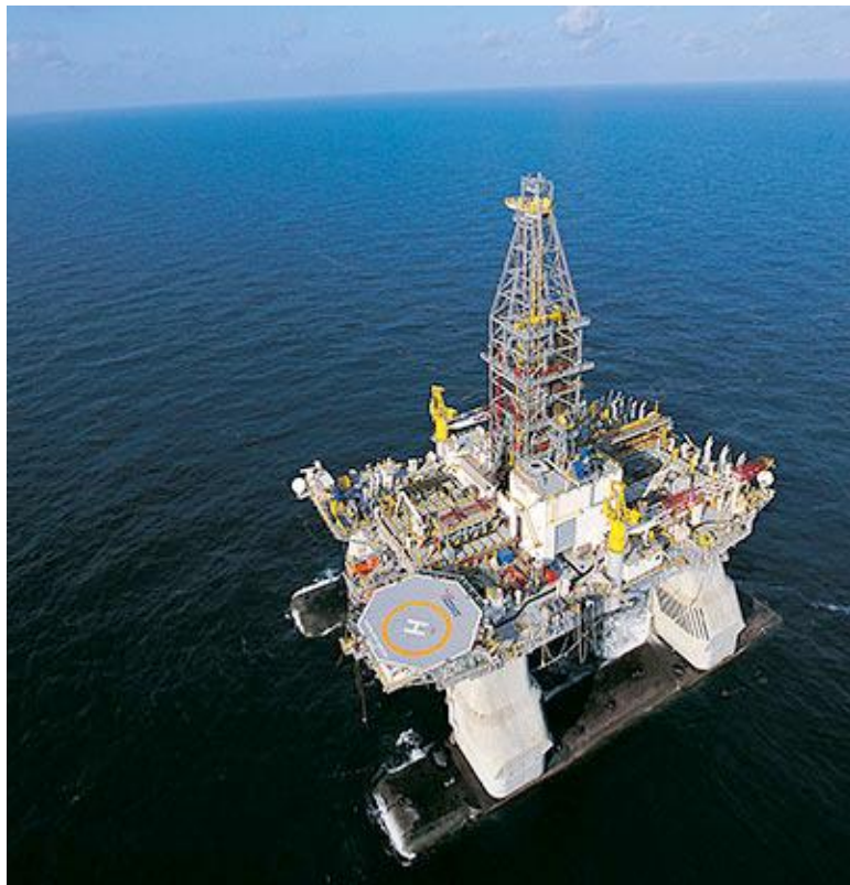
Εικόνα 3.6: Η ημιβυθιζόμενη εξέδρα Deepwater Horizon στον Κόλπο του Μεξικού. (Πηγή: Rigzone)
