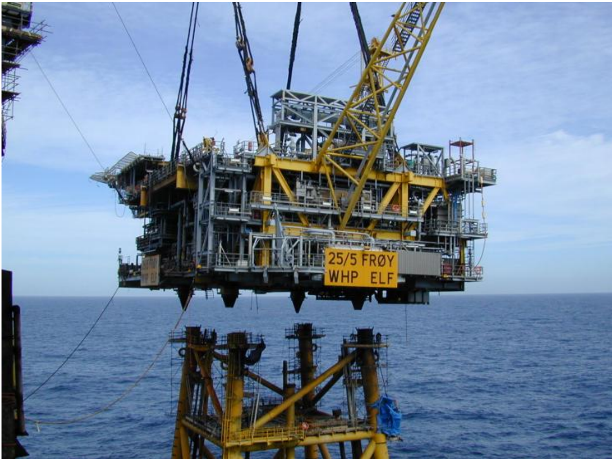
Εικόνα 3.1: Η εξέδρα τύπου jacket κατά τη φάση της τοποθέτησης της. (Πηγή: www.oilrig-photos.com )
