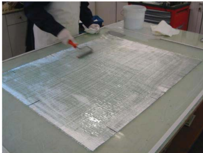
Εικόνα 3.11: Τοποθέτηση και εμποτισμός των υφασμάτων με ρητίνη
