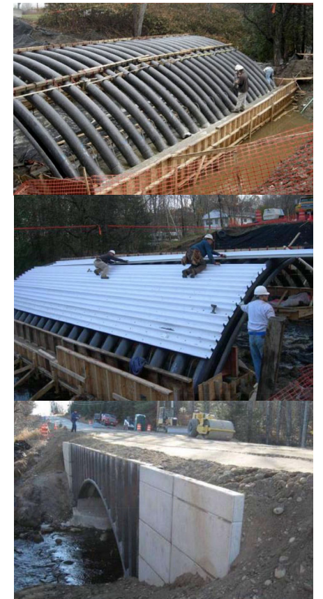
Στάδια κατασκευής μίας "Bridge-in-a-backpack". ( http://www.nesmea.uconn.edu )
