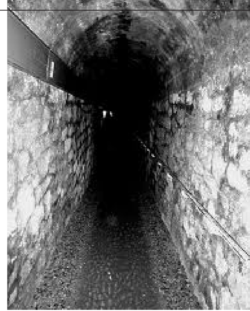
Εσωτερική άποψη υπονόμου.
