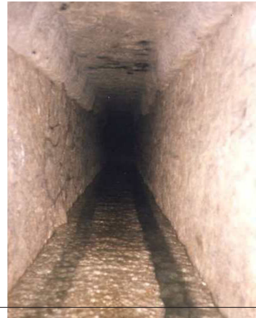
Εσωτερική άποψη υπονόμου.
