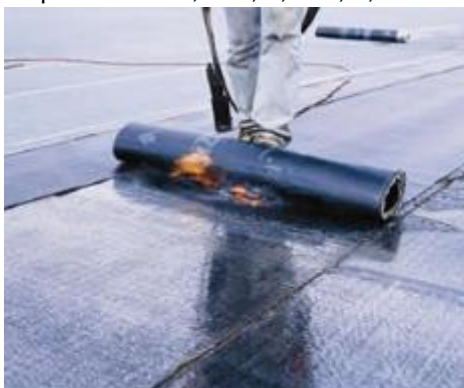
Σχήμα 11.5: Στεγανοποίηση δώματος με ασφαλτικές μεμβράνες
