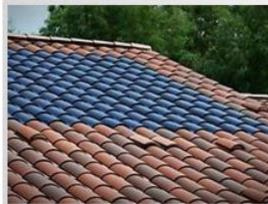
Σχήμα 4.10: Ενσωμάτωση ηλιακών κεραμιδιών σε στέγη [77]
