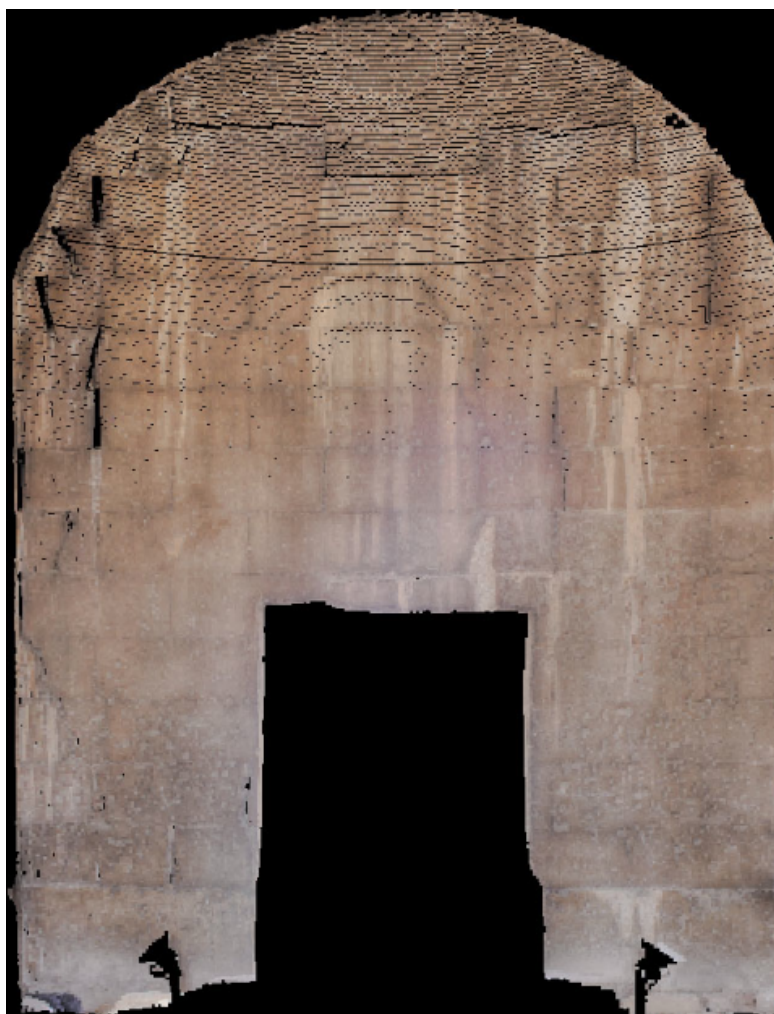
Εικόνα 3.16: Ορθοφωτογραφία δυτικής εισόδου. Κλίμακα 1:100. Καθορισμός επιπέδου από 3 σημεία.
