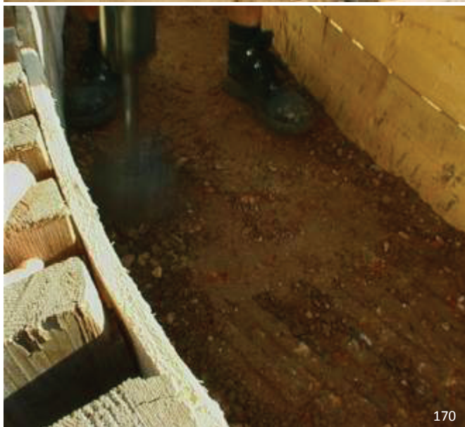
εικ.168: Πλατφόρμα από μπετόν για έδραση του κτιρίου εικ.169: Καμπύλος ξυλότυπος για rammed earth εικ.170: Συμπίεση του χώματος με ηλεκτρικό έμβολο εικ.171: Αεροφωτογραφία κατά τη διάρκεια κατασκευής του τοίχου από rammed earth
