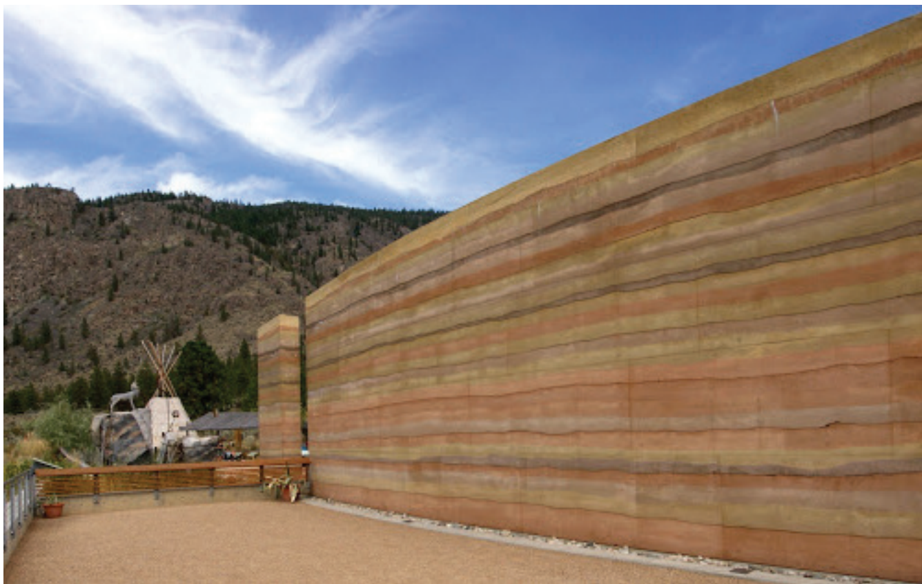
εικ.62: Οψη του Nk'Mip Desert Interpretive Centre στο Osoyoos του Καναδά, διαμορφωμένη από τοίχο rammed earth ύψους 6m με διακριτές ζώνες συμπίεσης, κάνοντας χρήση χώματος διαφορετικών αποχρώσεων.
