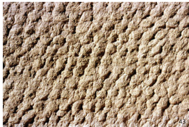
εικ.41: Σχεδιαστική αναπαράσταση κατασκευής tubali και χρήση τους στην κατασκευή εικ.42: Κατασκευή tubali εικ.43: Οψη τοίχου από tubali
