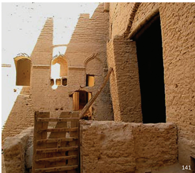
εικ.141: απόκόλληση τοίχους στήριξης της ράμπας για την καμήλα εικ.142: έντονη ριγμάτωση λόγω μετακίνησης του κτιρίου από την κατάρρευση της όψης
