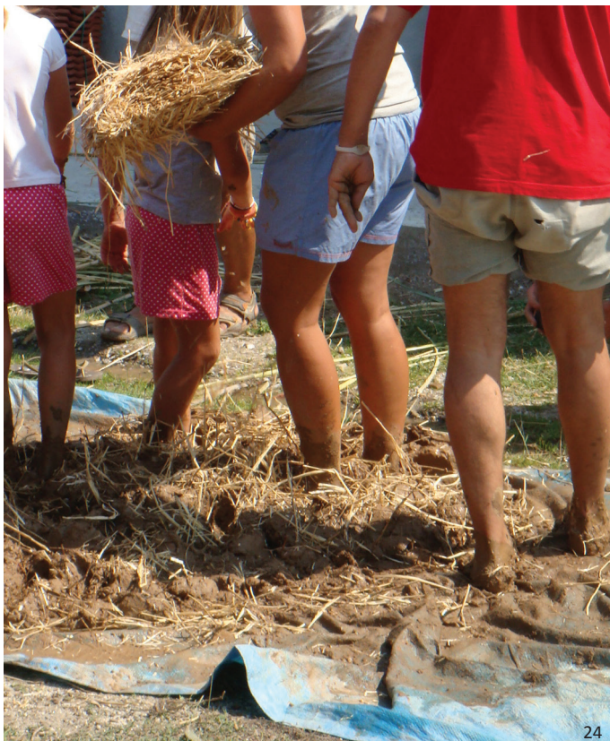
εικ.24,25: σταθεροποίηση μίγματος πηλού με την προσθήκη άχυρου (εικ.24) και τριχών γίδας (εικ.25)
