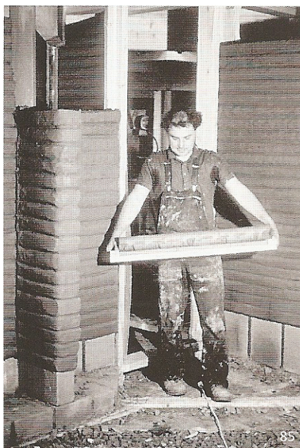
εικ.83: Μια κοινή λύση θερμομόνωσης τοίχων με δομικά στοιχεία από εξωθιμένο πηλό εικ.84,85: Παραγωγή και μεταφορά, αντίστοιχα, εξωθούμενων ρολών για τη κατασκευή κατοικίας στο Kassel (1984) εικ.86: Τοίχος κατασκευασμένος με την τεχνική “stranglehm” σε κατοικία στην Uchte της Γερμανίας (1986)
