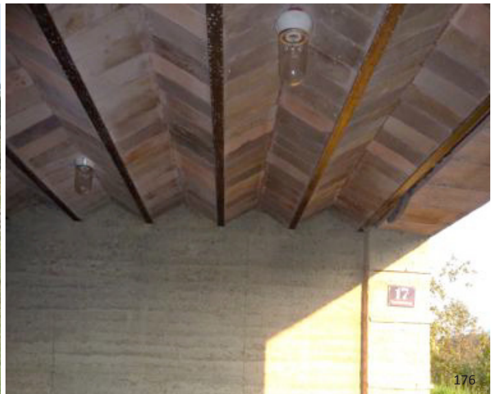
εικ.174 (αριστερά), 175 : Κατοικία Rauch στην Αυστρία εικ.176 : Οροφή που διαμορφώνεται από μεταλλικά δοκάρια και ψημένα τούβλα υπό κλίση
