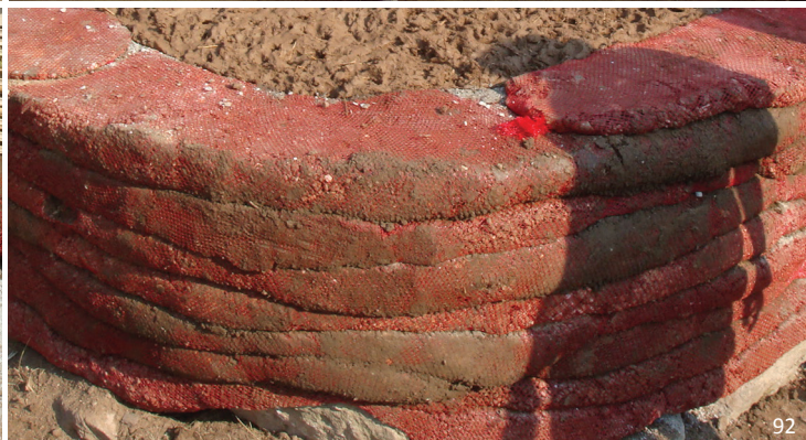
εικ.89,90: Κατασκευή από “superadobe”, Nader Khalili, California, ΗΠΑ εικ.91: Γέμισμα σωλήνα αραϊκής ύφανσης με χώμα που στη συνέχεια συμπιέζεται δημιουργώντας ένα συμπαγή και σταθερό τείχος ( εικ.92 )
