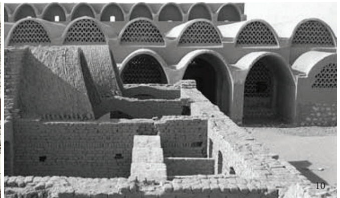
εικ.7: Αποθήκες του Ραμσείου στεγασμένες με κυλινδρικούς θόλους εικ.8: Σχέδιαστική αναπαράσταση κατασκευής κυλινδρικών θόλων με ωμές πλίνθους στην αρχαία Αίγυπτο εικ.9: Κατασκευή θόλων για εκπαίδευση τεχνητών με πρωτοβουλία του Hassan Fathy εικ.10: Θολωτές κατασκευές από ωμόπλινθους στο χωριό New Baris σχεδιασμένο από τον Hassan Fathy
