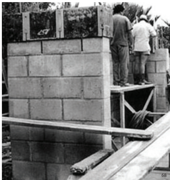
εικ.66,67,68: Κατασκευή δόμων κατευθείαν πάνω στον τοίχο με ρευστή γη μέσα σε καλούπια - ξυλότυπους
