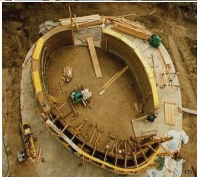
εικ.168: Πλατφόρμα από μπετόν για έδραση του κτιρίου εικ.169: Καμπύλος ξυλότυπος για rammed earth εικ.170: Συμπίεση του χώματος με ηλεκτρικό έμβολο εικ.171: Αεροφωτογραφία κατά τη διάρκεια κατασκευής του τοίχου από rammed earth
