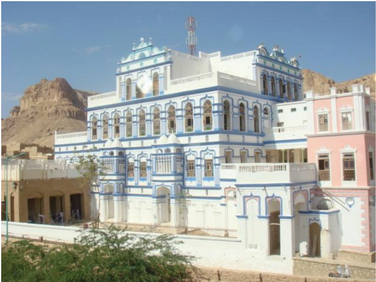
εικ.134: Αρχοντικό Qasr al-'Ishshah στο Tarim της Υεμένης, όπως είναι σήμερα αποκατεστημένο
