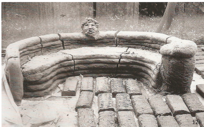
εικ.126: Παγκάκι από χώμα στο οποίο εμφανίστηκαν μεγάλες ρωγμές συρρίκνωσης μετά το στέγνωμα του υλικού της κατασκευής τοίχων από χώμα αποτελεί το γεγονός ότι έντομα και τρωκτικά μπορούν να φωλιάσουν στη μάζα τους, δημιουργώντας κοιλότητες και καταστρέφοντας το υλικό. Κτίσμα από ωμόπλινθους στο οποίο έχουν φωλιάσει σφήκες (N. Κοζάνης)
