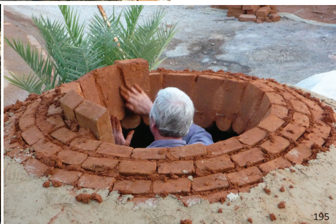
εικ.191-195: Εικόνες από το 3ο Κατασκευαστικό Σεμινάριο με θέμα την “κατασκευή θόλου με πλίνθους”, στην Παλαιόχωρα της Κρήτης, με τον καθηγητή Gernot Minke του Πανεπιστημίου Kassel της Γερμανίας, οργανωμένο από την ομάδα ΠηλοΟίκο, Ιούλιος 2011
