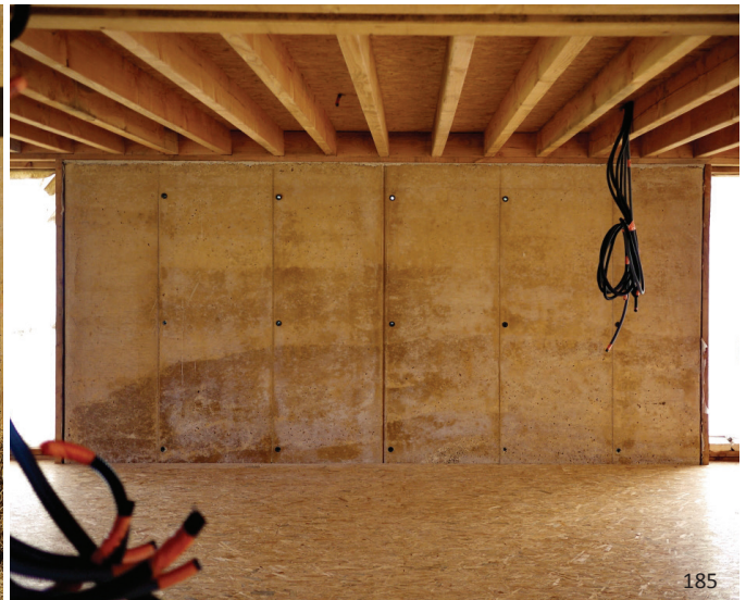
εικ.182: Εξωτερική άποψη του κτιρίου στο Sassenage εικ.183: Πλήρωση ξύλινου σκελετού από αχυρόματα εικ.184,185: Νότιος τοίχος από χόμα
