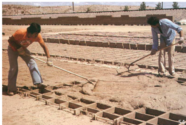
εικ.52: Μεταφορά μίγματος πηλού σε καλούπι μεγάλων διαστάσεων εικ.53: Σκίσιμο κοπής πλίνθων που προέρχονται από ένα μεγάλο καλούπι, με τη χρήση πριονιού εικ.54: Παραγωγή πλίνθων ρίχνοντας υγρό χώμα σε μεγάλα καλούπια (New Mexico των ΗΠΑ)
