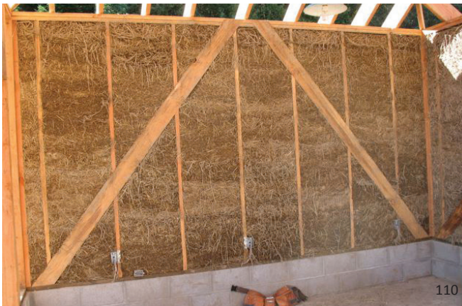
εικ.110: Τοίχος από straw clay πάνω σε βάση από τσιμεντόλιθους σε ξενώνα εξοχικής κατοικίας (ΗΠΑ)
