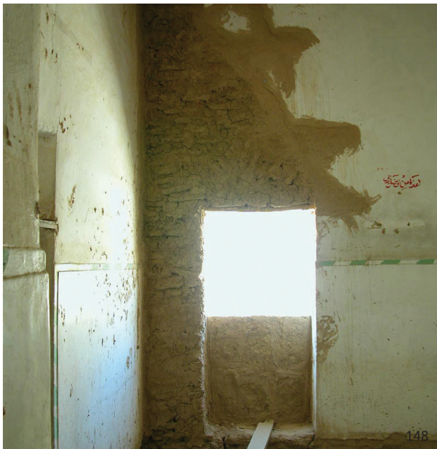
εικ.146: Αποκατάσταση τμήματος του στηθαίου με την προσθήκη νέου υλικού και δημιουργία συρραφής μεταξύ νέου και παλιού υλικού εικ.147: Αποκατεστημένη οροφή στο Dar Dawil εικ.148: Συμπλήρωση τμήματος τοίχου που είχε καταρρεύσει εικ.149: Αποκατάσταση οροφής μπάνιου στο κυρίως κτίριο με την προσθήκη και σωλήνων αντί για ξύλινα δοκάρια λόγω οικονομίας
