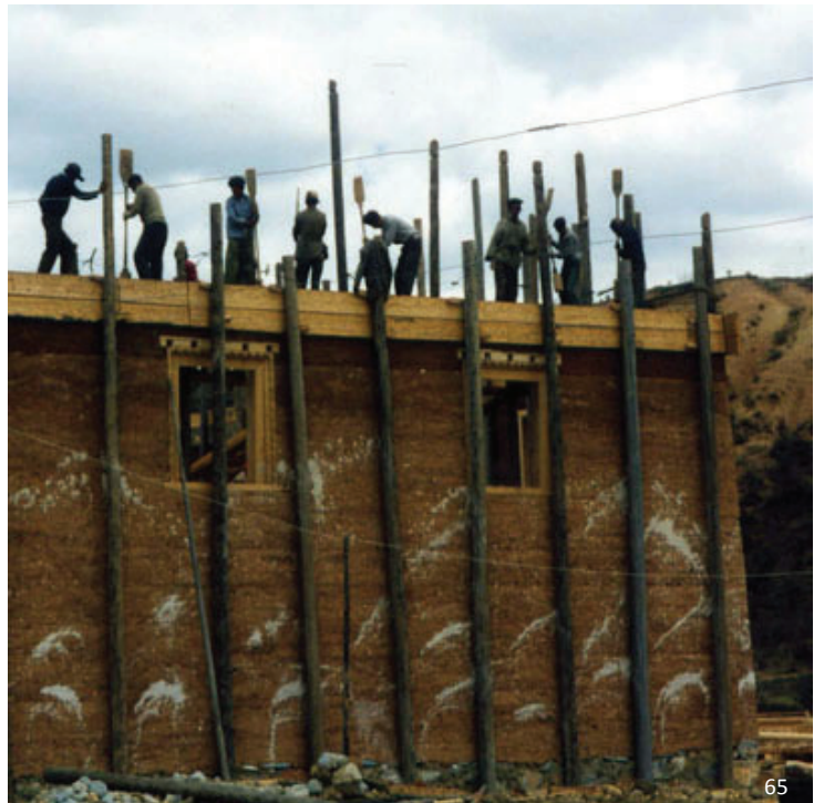
εικ.63: Διαδικασία συμπίεσης rammed earth στην περιοχή του Βόρειου Ατλαντα στο Μαρόκο εικ.64: Κτίριο Tulou του 17ου αιώνα στην Κίνα εικ.65: Κατασκευή rammed earth τοίχου στην Κίνα
