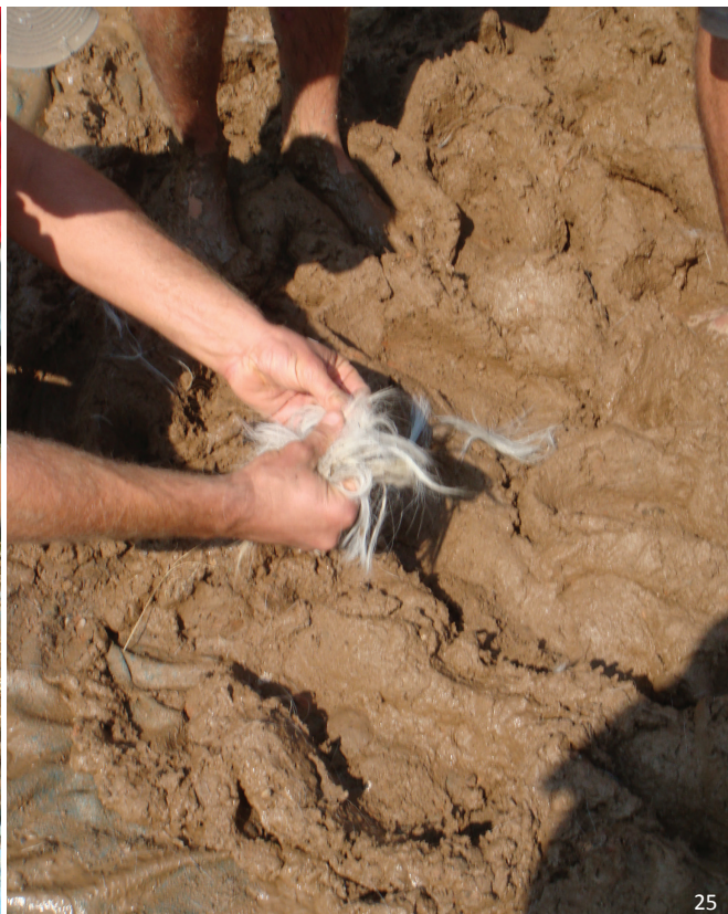
εικ.24,25: σταθεροποίηση μίγματος πηλού με την προσθήκη άχυρου (εικ.24) και τριχών γίδας (εικ.25)
