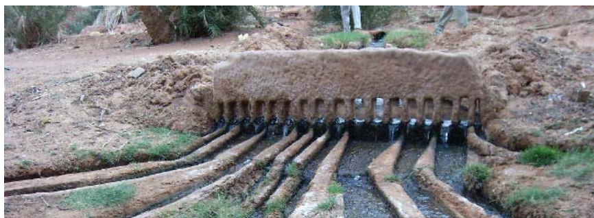
Εικ.37: Khettaras. Η έξοδος του υπόγειου αγωγού και η κατανομή του νερού σε αρδευτικά κανάλια. Η μέθοδος αυτή συναντάται σε ολόκληρο το Maghreb. [Πηγή: Convention on Biological Diversity, http://www.cbd.int/ ]
