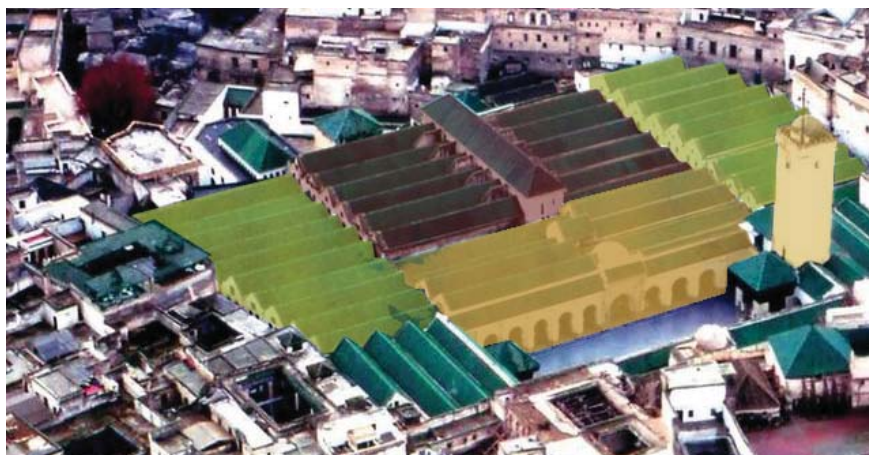
Εικ.17: Φεζ. Το τέμενος al Qarawiyyin: Διακρίνουμε τρεις φάσεις κατασκευής. Παρατηρούμε ότι οι φάσεις είναι ευδιάκριτες τόσο στο εξωτερικό του τεμένους, με την ανισοσταθμία της στέγασης, όσο και στην κάτοψη, με τα εγκάρσια τόξα και τις ισχυρές στηρίξεις τους να υποδηλώνουν τα όρια των παλαιότερων φάσεων. [Φωτογραφία: http://www.skyscrapercity.com . Κάτοψη: http://www.archnet.org , Keith Turner, MIT Libraries, Aga Khan Documentation Center]
