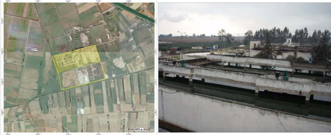
Εικόνα 4.3.4.5.2: Ο βιολογικός καθαρισμός λυμάτων Καλαμάτας.
