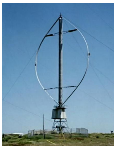
Εικόνα 3-8: Α/Γ τύπου Darrieus
